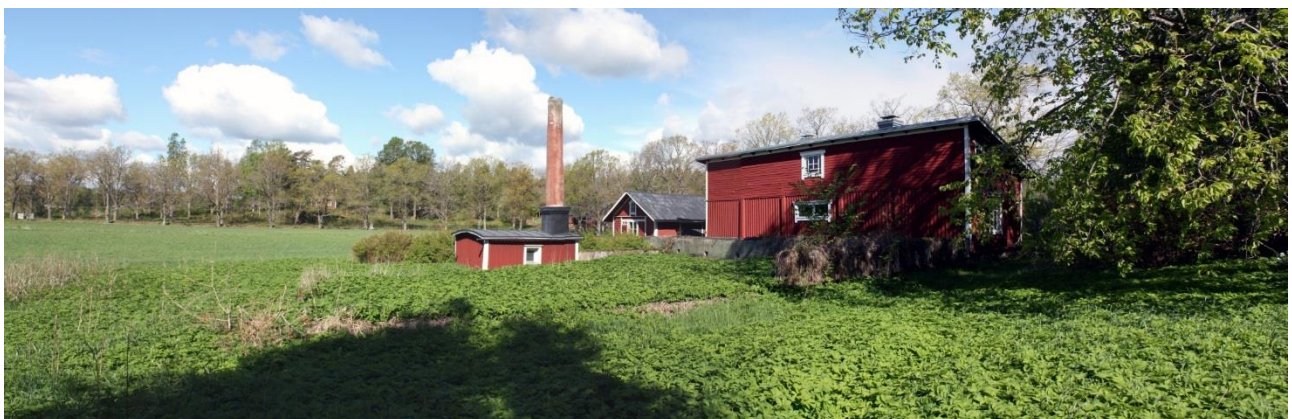
Kuva 2. Puutarhurin talon takapiha, jossa on purettujen kasvihuoneiden betoniperustuksia. Kuvattu kaakosta. AKDG 5289:2
