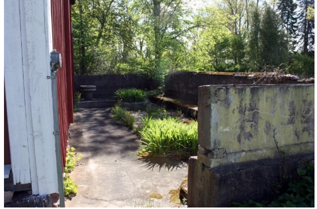
Kuva 4. Puutarhurin talon eteläpuolella oleva kasvihuoneen betoniperusta, kuvattu lännestä. AKDG 5289:5
