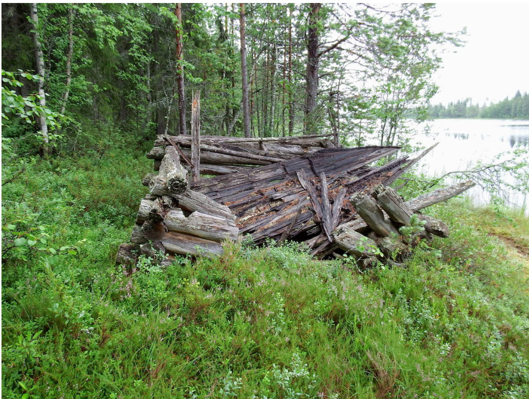
Rakennusjäänös kuvattuna lännestä. Kattorakenteet ovat romahtaneet. Suoraan edessä on oviaukko.
