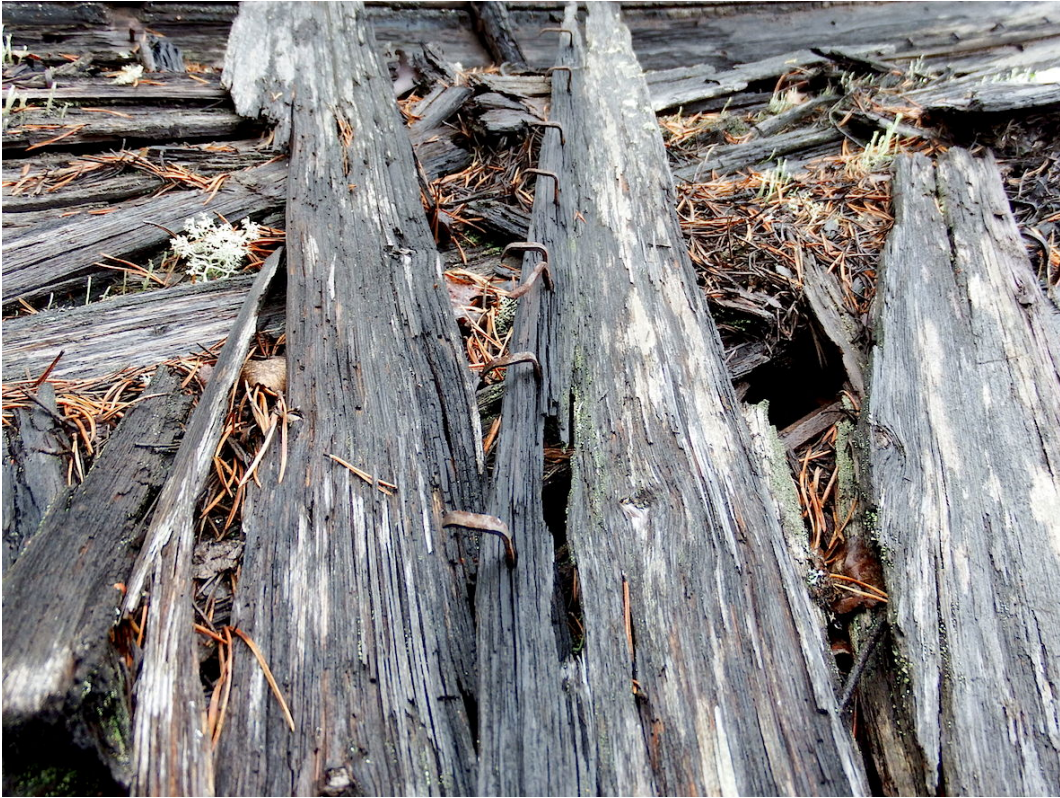
Kattorakenteissa olevia taottuja nauloja.
