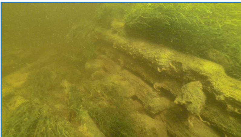
Kuva 9. Arkku 1. Arkun ehjää sivua rannan puolella. Arkku on tehty vahvarakenteiseksi välihirsillä (etualalla).
