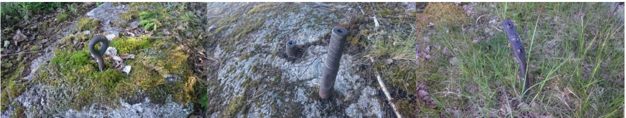
Kuvat 12-14. Kiinnityslenkki ja rautatappeja kolmessa eri paikassa länsirannan rantakallioissa.
