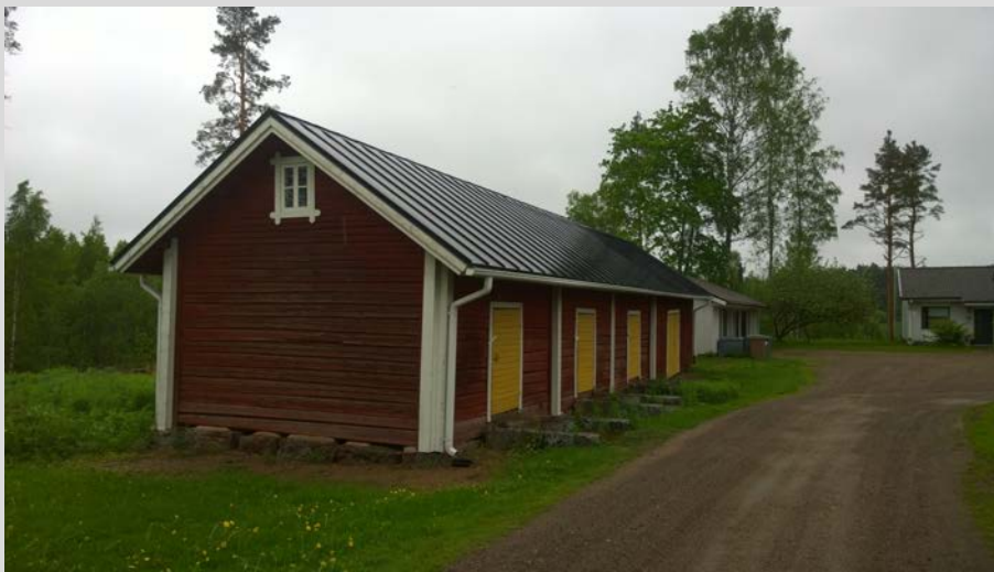
AKDG 5263:23. Punamulta- maalattu aitta. Kuvaaja: Petro Pesonen.
