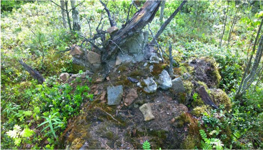
AKDG 5267:15. Tiiliä tuulenskaadossa talonraunion vieressä. Kuvaaja: Petro Pesonen.
