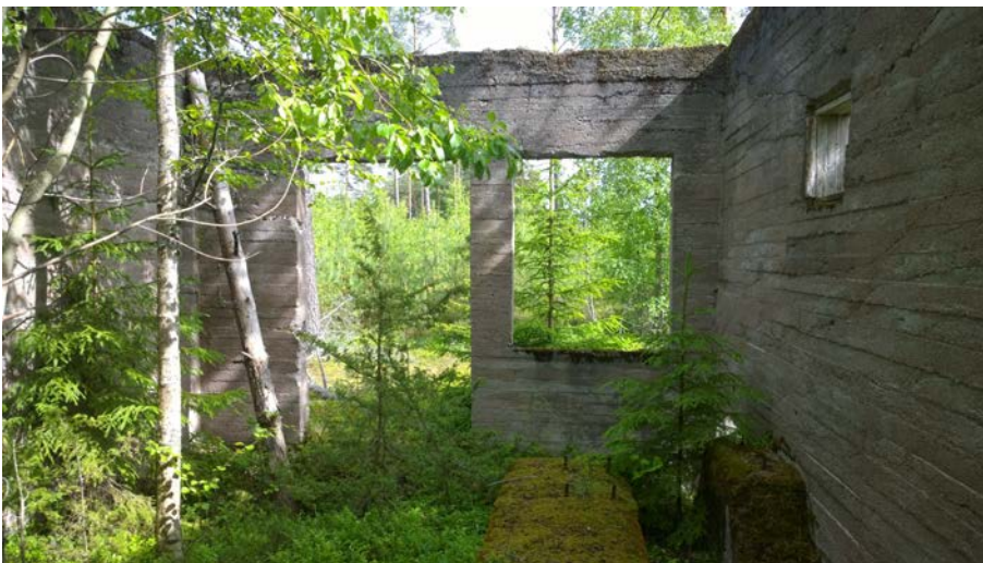
AKDG 5267:18. Betonitalon runko sisältä. Kuvaaja: Petro Pesonen.
