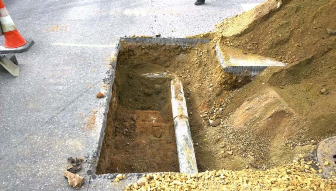
AKDG 5306:2. Vanha kaukolämpöputki Vuorikadun ja Pohjoistullikadun risteyksessä, pohjoisesta. Kuvaaja: Petro Pesonen.
