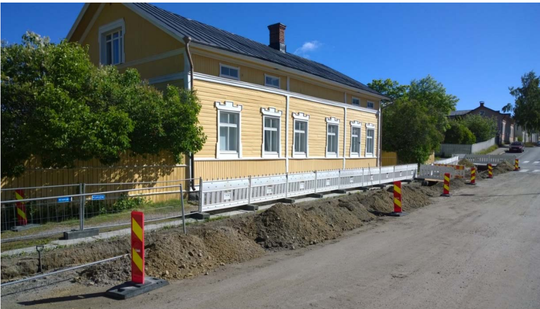
AKDG 5306:6. Kaivanto Vuorikatu 19 edustalla, lounaasta. Kuvaaja: Petro Pesonen.
