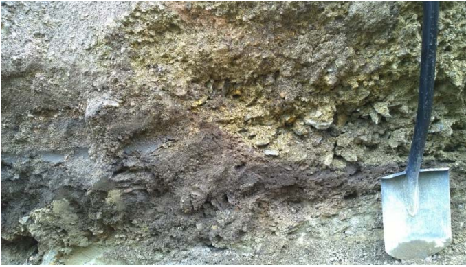
AKDG 5306:5. Kaivannon profiili Vuorikatu 19 kohdalla, pohjoisesta. Kuvaaja: Petro Pesonen.
