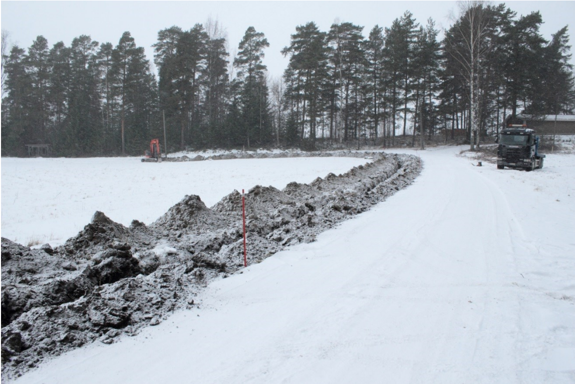
Kuva 3. Asikkala Ojaintien pelto. Valvottu kaapelikaivanto muinaisjäännösalueen reunalla. Ojan päädyssä, kaivinkoneen luota, kaivanto siirtyy tien yli metsän puolella ja kääntyy kohti pohjoista. Pelto on savea tai silttiä, mutta sen korkeimmalla (risteysalue sekä siitä etelään kaivinkoneen luokse) kohdalla on hiekkaa ja soraa. Kuvattu idästä. (DIGMAV2017001:4)
