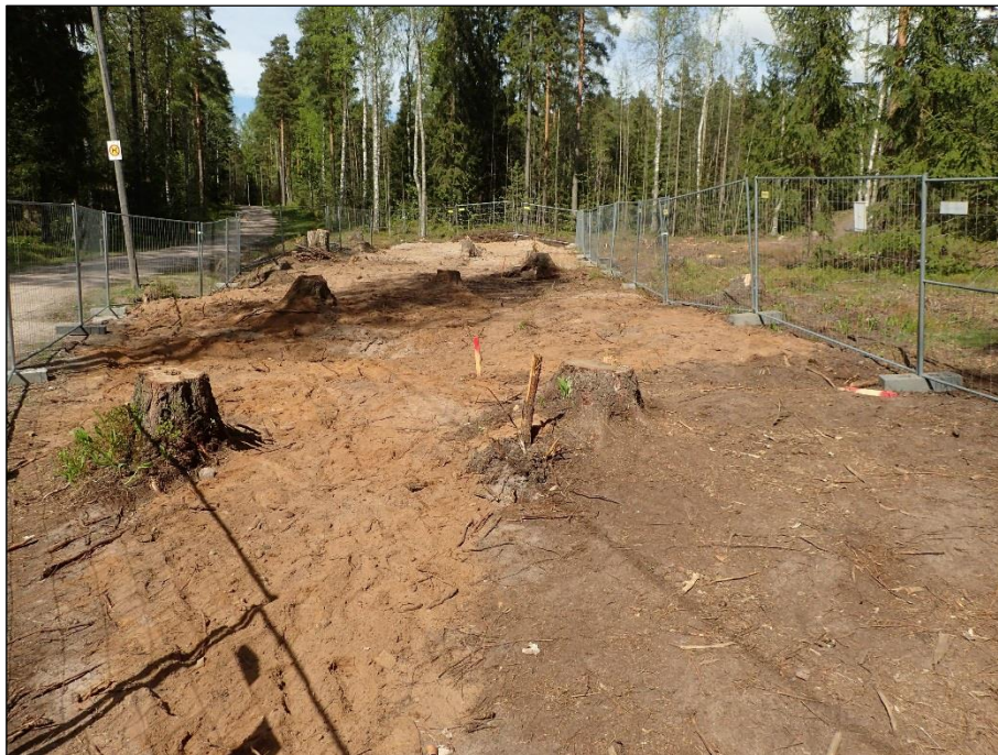
Kaivaus on päättynyt ja kaivausalue on täytetty ja tasoitettu, pohjoiseen.
