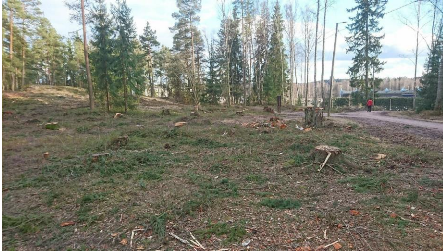
Kaivausalue ennen kaivautta, kun puut on kaadettu, etelään.
