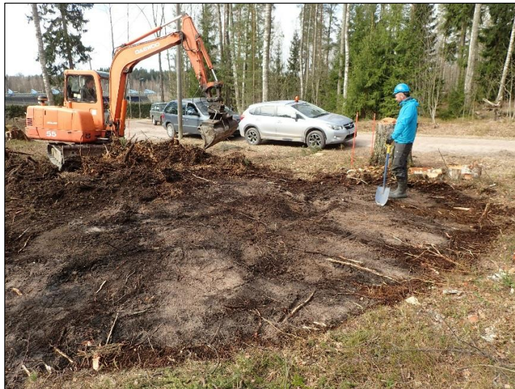
Turvetta ja kunntaa poistetaan koneellisesti
