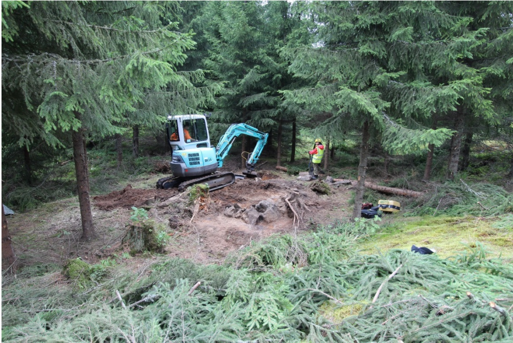
AKDG5270:18 Torvimiilun länsiosaan avataan kaivinkoneella koeojaa 2. Myös kiviunin edustaa on kuorittu koneella. SE-NW. Kuva Katja Vuoristo.
