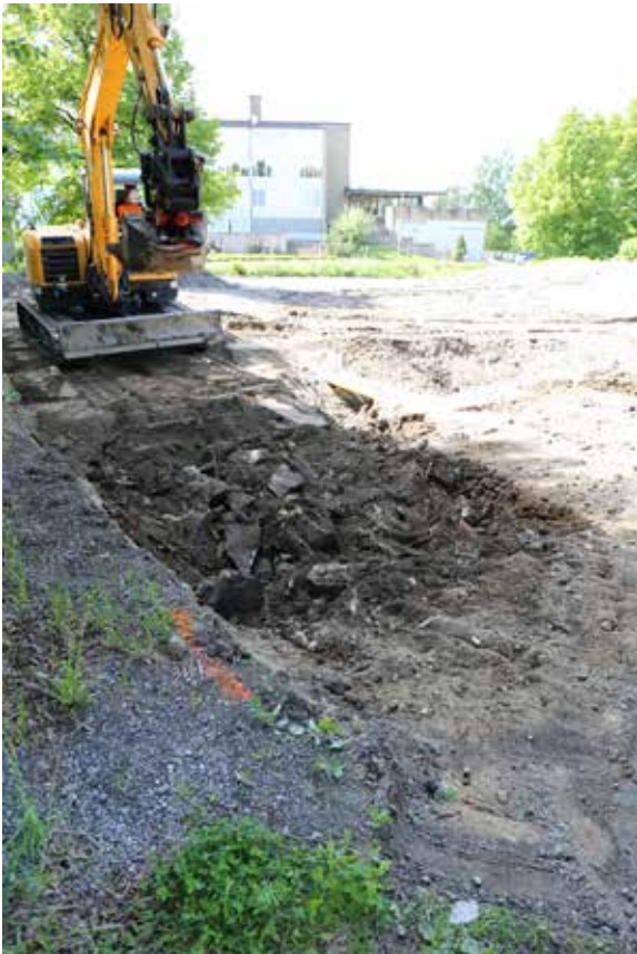
DT2017:67:72: Kivilouhikkotäyttö M208 kentän etelälaidassa. Idästä/ Maija Helamaa
