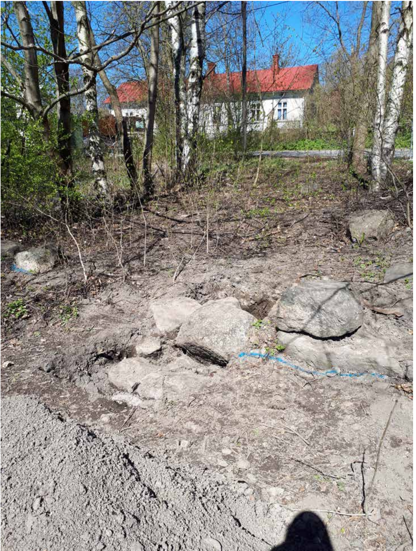
MuTu117013:3. Rakennuksen 1 perustuskivet kaakon suunnalta. SE. KU
