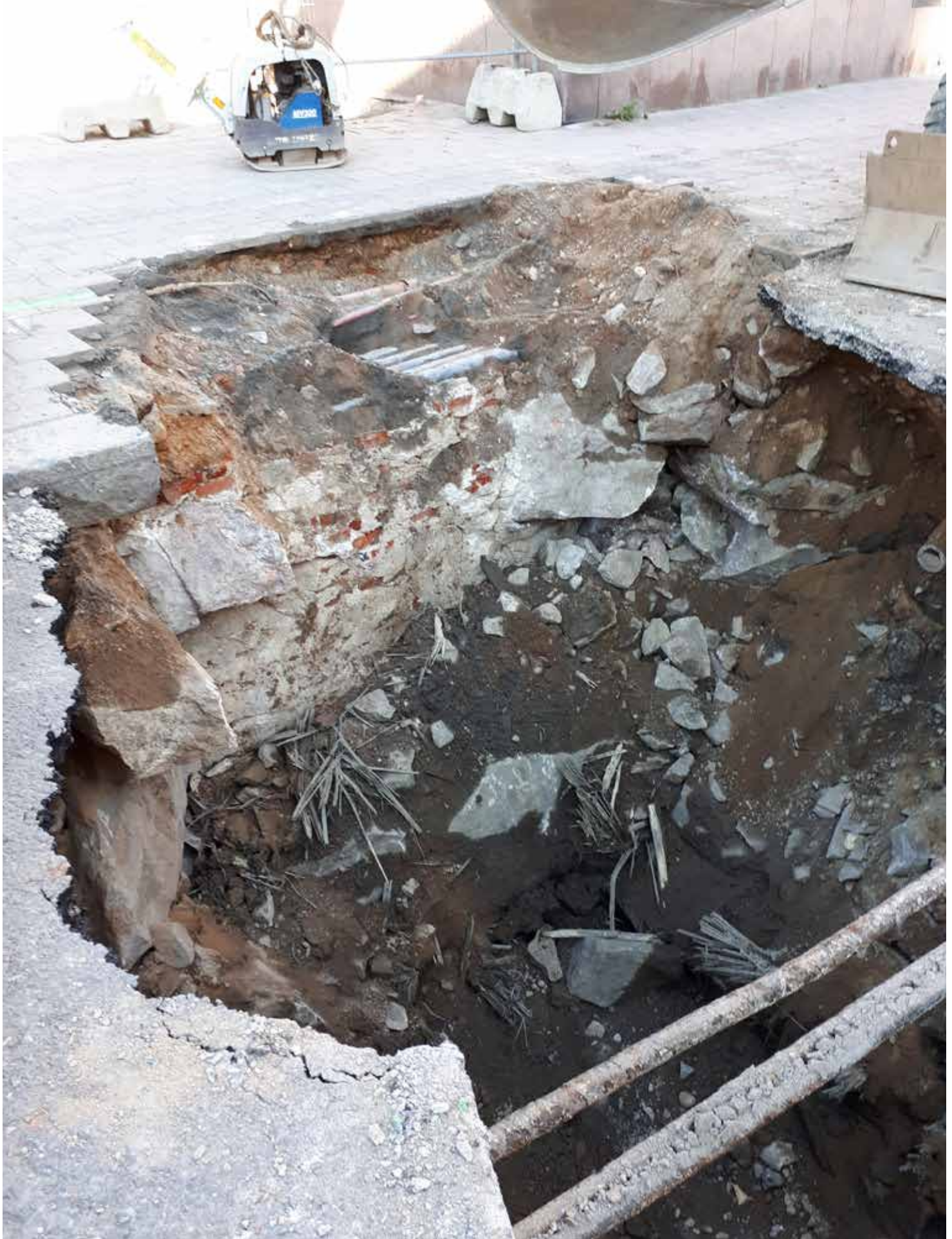
MuTu117017:2. Kivinen perusrakenne pääosin purettuna ja esillä kellarin tiilinen sisäseinä. Kuopan pohjalla rikkonaisia hirsjarinan ja kiviperustuksen osia. SE. KU.
