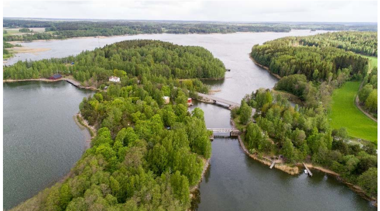
Kuva8. Strömman vanha kanava ja sen yli johtava rullasilta.
