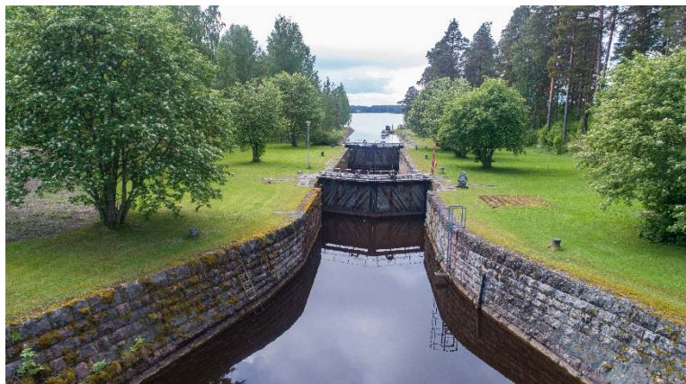
Kuva 5. Ahkiolahden vanha sulkukanava.
