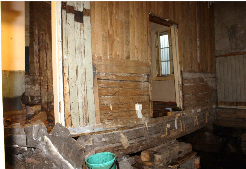
AKDG 5371:4. Huoneen pohjoisseinä, vasemmalla uunin tai savupiipun perustuksen päälle kasattuja lokkokiviä, taustalla vasemmalla hormin alaosa, kuvattu etelästä.
