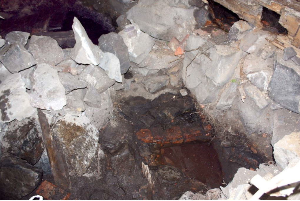
AKDG 5371:7 Huoneen etelänurkan tiili- ja kivirakenne, kuvattu lännestä.
