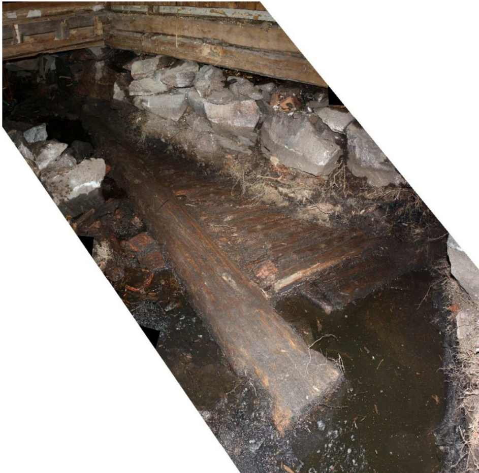
AKDG 5371:6. Lattian ja itäseinän kivijalan ala oleva puurakennelman pääty, poikisahatun hirren pään alapuolella oli lovi, joka oli kiven päällä, nauvoja eikä niiden reikiä havaittu, kuvattu länsilounaasta.
