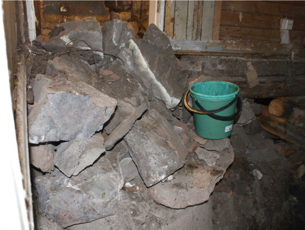
AKDG 5371:3. Huoneen länsi- ja pohjoisseinän nurkkauksen uunin tai savupiipun perustus, jonka päälle kasattuja lokkokiviä, kuvattu eteläkaakosta.
