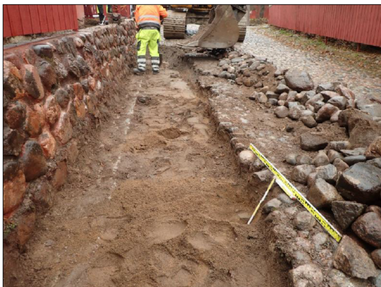
Kadun laidalla kaivettiin maata aidasta n. 1,1 -1,2 m leveydeltä.
