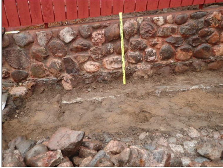
Nupukiveyksen alta paljastui kadun alle n. 25 cm ulottuva aidan betoniperusta
