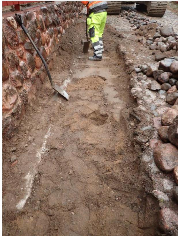
Nupukiveyksen alta paljastui kadun alle n. 25 cm ulottuva aidan betoniperusta
