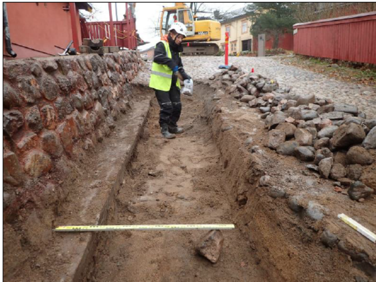
Kadun profiili, nupukiveyksen alla kaksi hiekkakerrosta ja sen alla sorainen kerros
