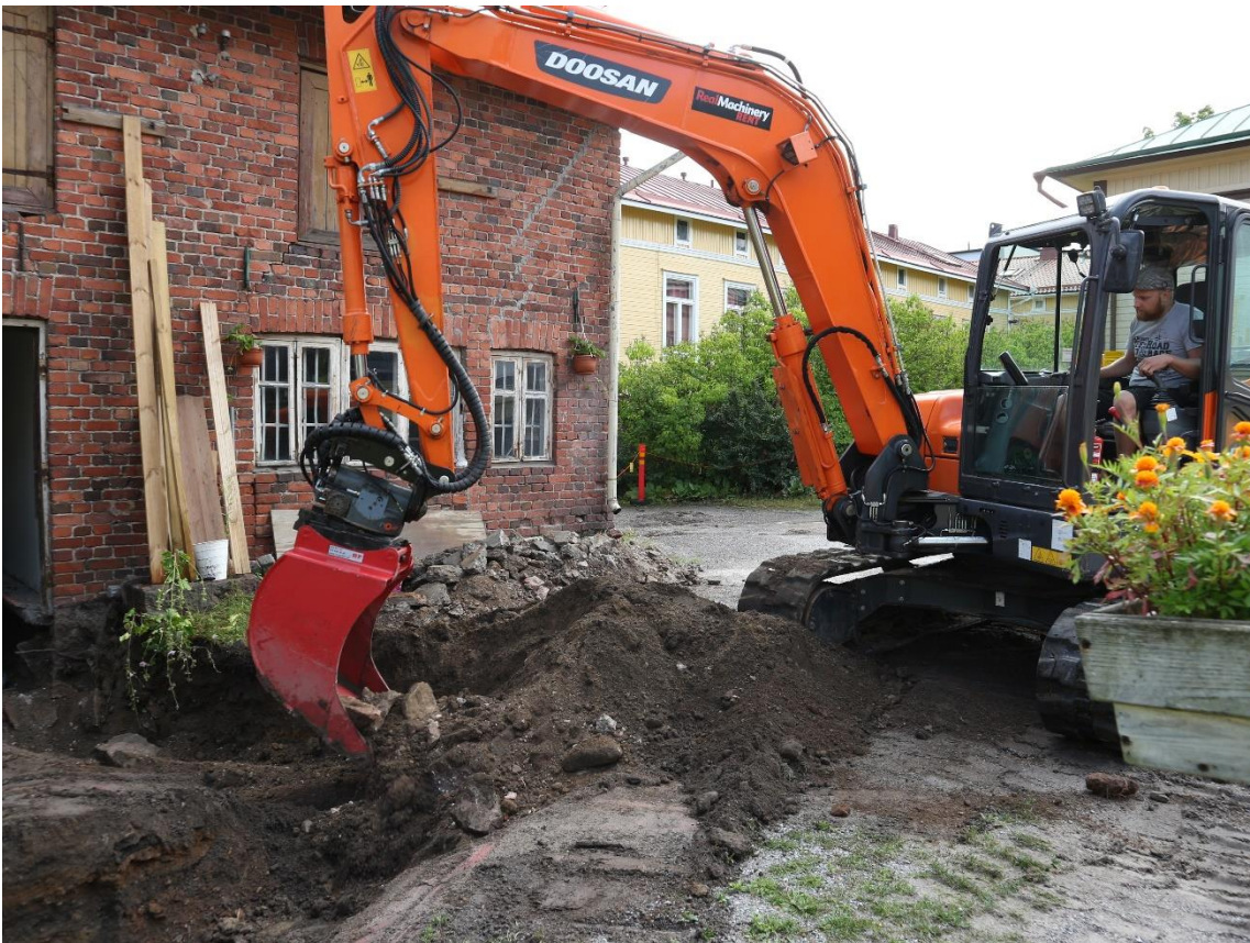
ARB2017:5:2 Kalle Salminen avaa kaivantoa lämmönjakuhuoneen edustalla. Kuvaaja Elina Saloranta.
