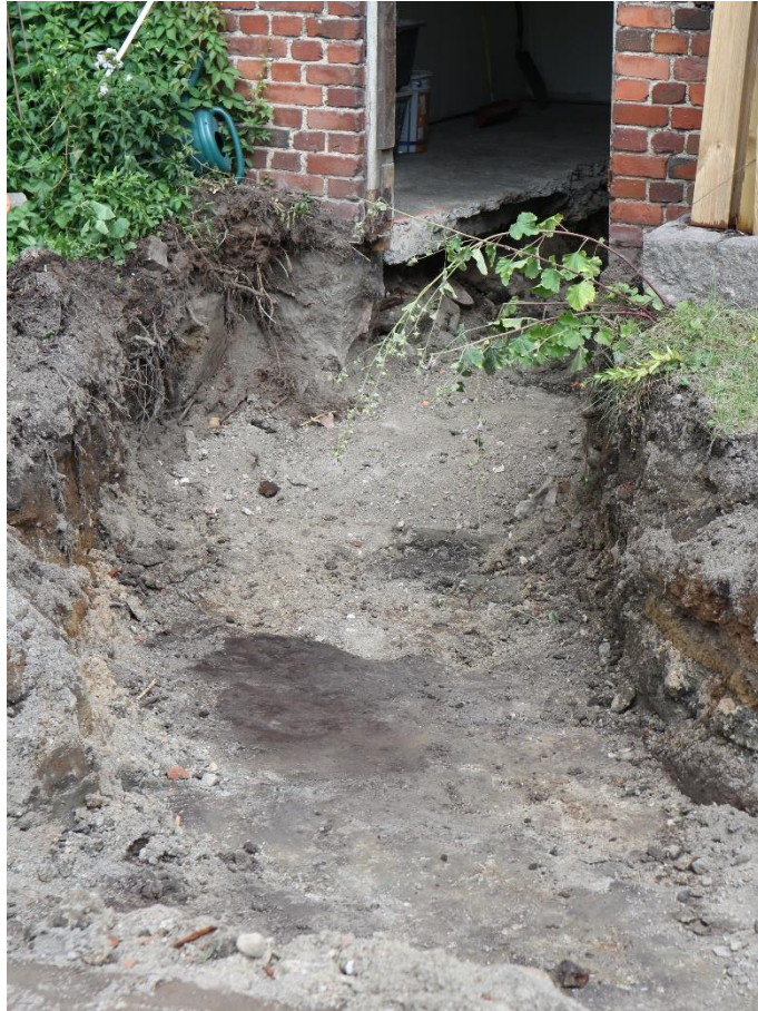
ARB2017:5:3 Lämmönjakuhuoneen edustan kaivanto pohjaan kaivettuna. Kuvattu lounaasta. Kuvaaja Elina Saloranta.
