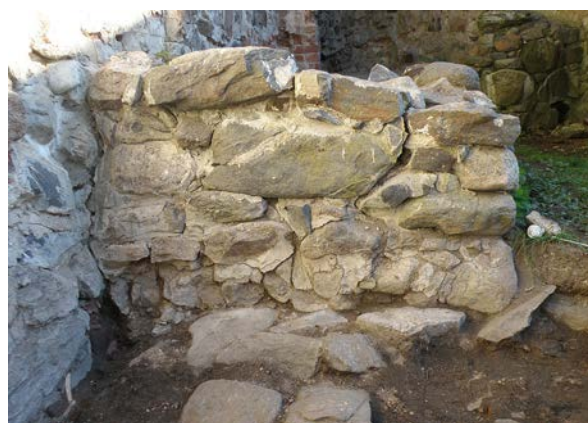
Kuva 7. Vuonna 1942 rekonstruoidun kiviperustan S-seinä. Kuva: G. Haggrén.
