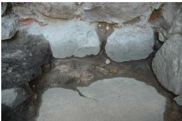
Kuva 20: Koillisen kulmahuoneen itäinen muuri on muurattu suoraan peruskallion pinnalle. Kuva T. Knuutinen.
