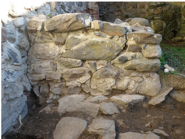
23. Alue 9A. Vuonna 1942 rekontruoidun kiviperustan S-seinä. S-N. GH.
