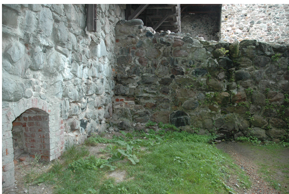
54. Alue 12A. Alueen 12A paikka ennen kaivausta. NE-SW. TK.
