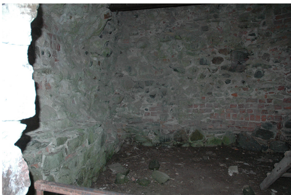
24. Alue 10A. Alue 10A, pohjoistornin NW-nurkka ennen kaivausta. S-N. TK.
