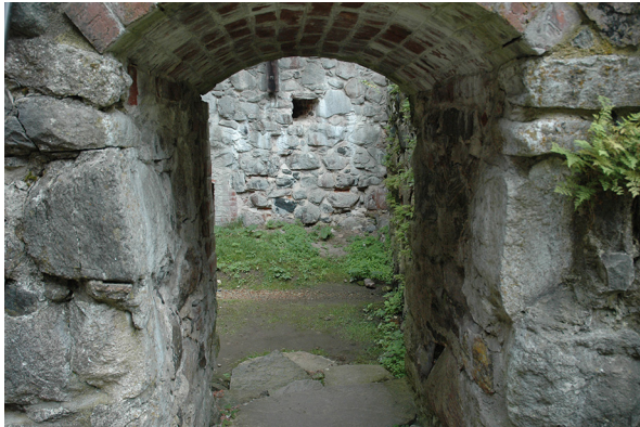
52. Alue 12A. Alueen 12A paikka ennen kaivausta huoneen ovelta katsottuna. W-E. TK.
