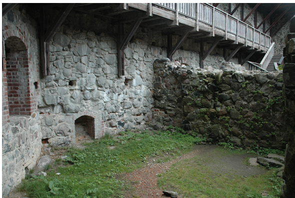
53. Alue 12A. Alueen 12A paikka ennen kaivausta. NE-SW. TK.
