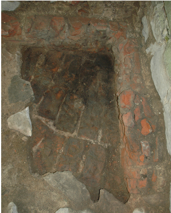
48. Alue 10A. Taso 3. Palossa vaurioituneen tiililattian R10A-10 pinta ja seinänvierustan tiilimuuraus R10A-9. E-W. ET.
