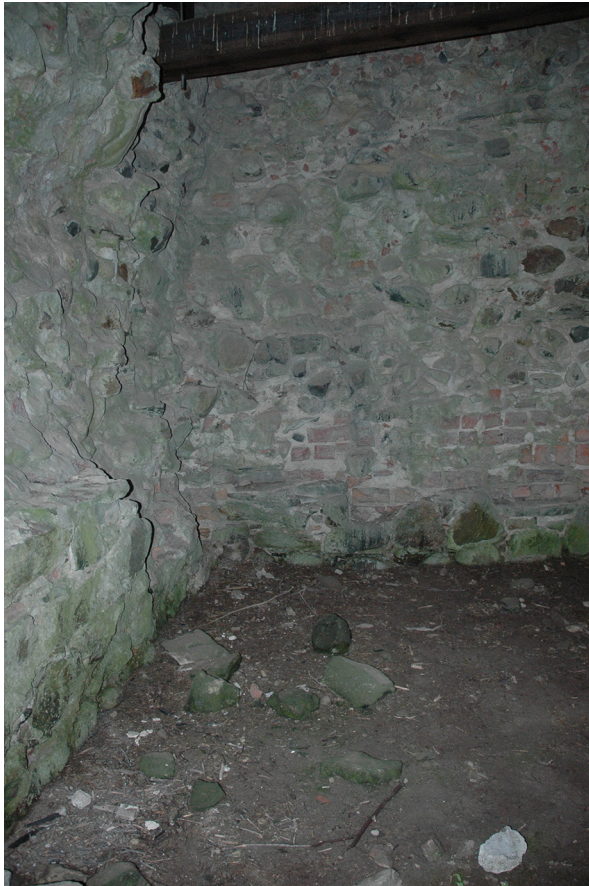
27. Alue 10A. Alue 10A ennen kaivausta. S-N. TK.
