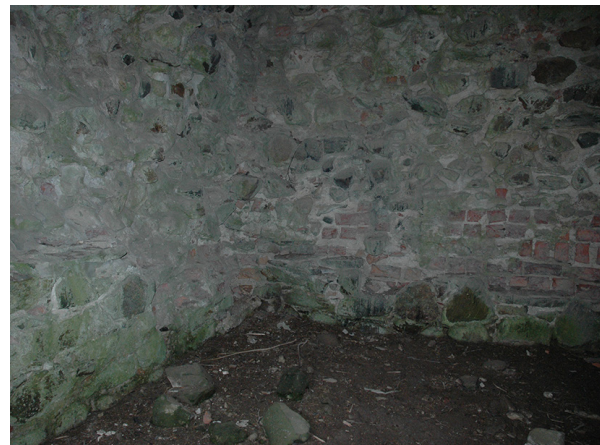
26. Alue 10A. Alue 10A ennen kaivausta. SE-NW. TK.
