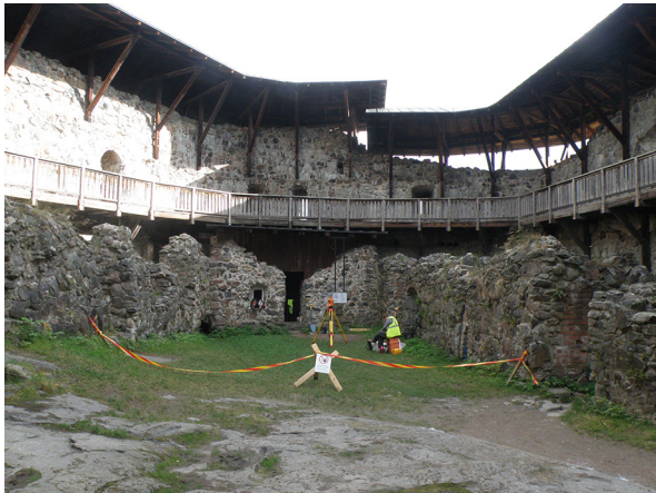
1. Yleiskuva linnanpihasta. Pihan perällä oikealla huone 9, keskellä huone 10 ja vasemmalla huone 12. S-N. GH.
