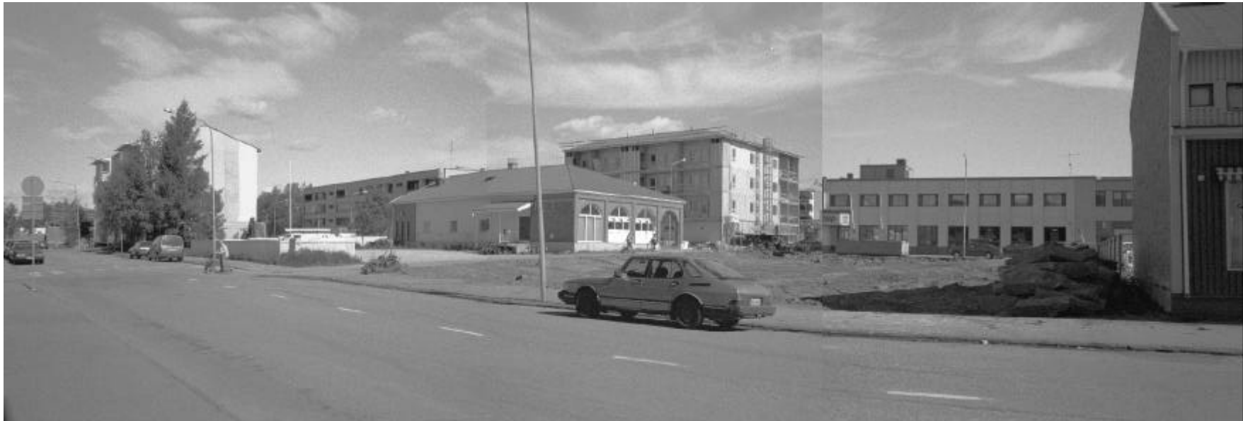
124530: 28-30. Panoraama. Keskellä vasemmalla tontin 00200030009 kauppahuoneisto ja parkkipaikka, jonka alaiset kulttuurikerrokset ovat todennäköisesti säilyneitä. Keskellä oikealla tyhjä tontti 00200020004. Molemmat tontit ovat 1. luokan aluetta. Kuva otettu Jääkärikadulta. Kohti N-E.
