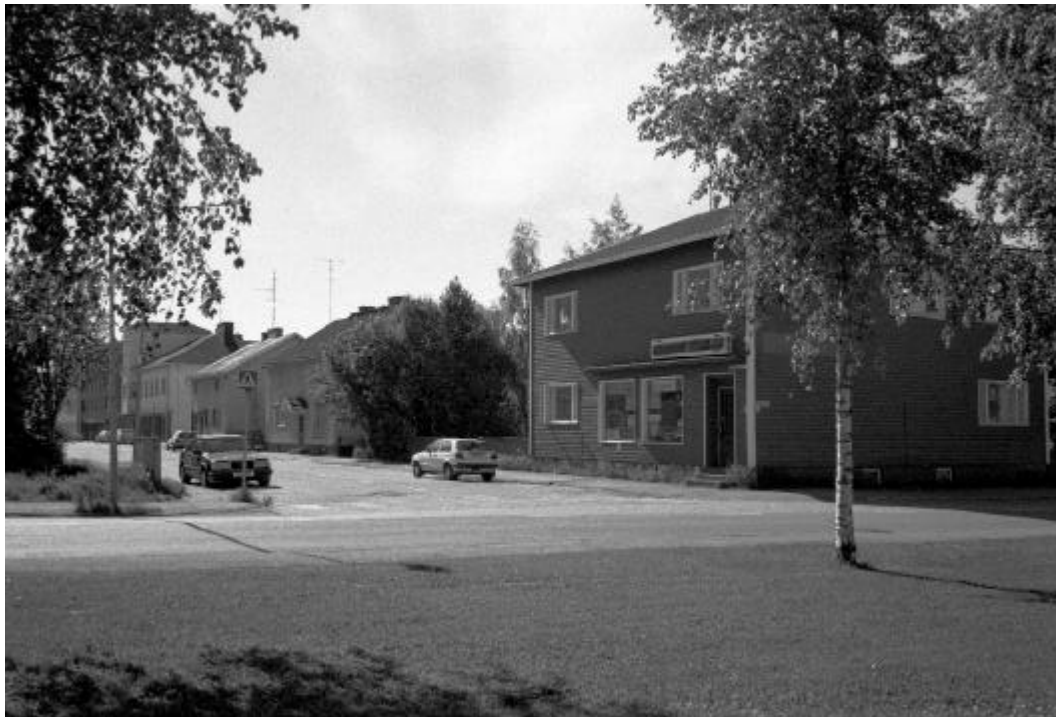
124530: 25. Kaksikerroksinen puurakennus Jääkärinkadun ja Torikadun kulmassa (tontti 00200110038) sijaitsee 1600- ja 1700-lukujen silloisen Rantakadun länsipuolella rantavyöhykkeellä, jossa karttojen perusteella on sijainnut makasiinirakennuksia. Kohti S.
