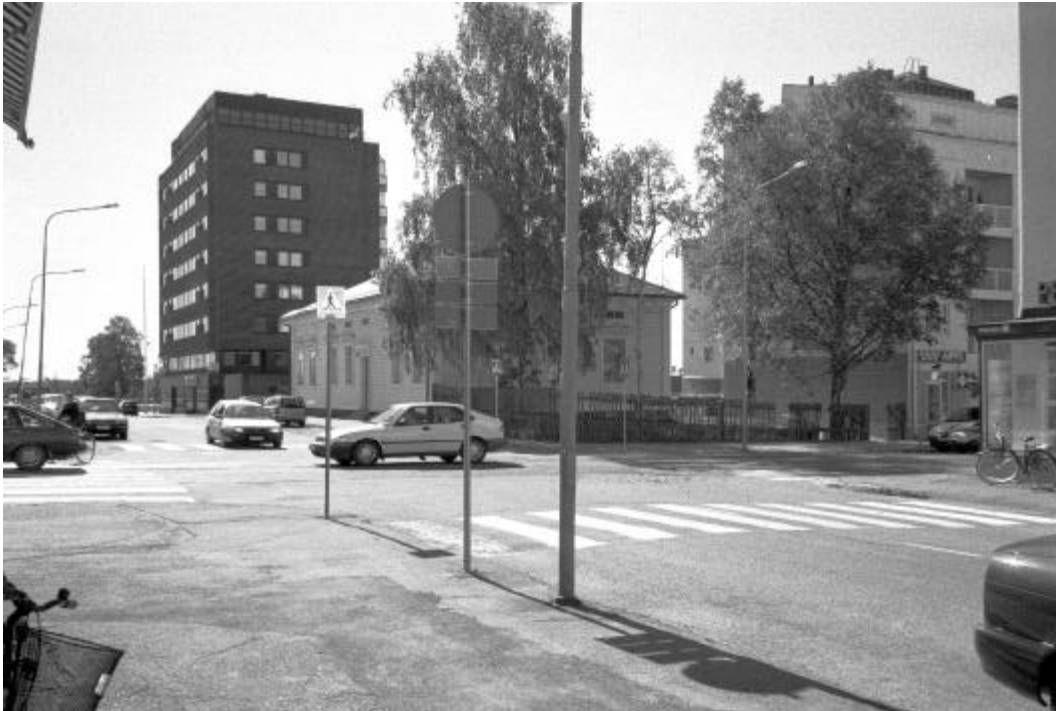
124530: 31. Risteyksen takana Husan v. 1857 rakennettu puutalo (tontti 00100020004). Kohti S.
