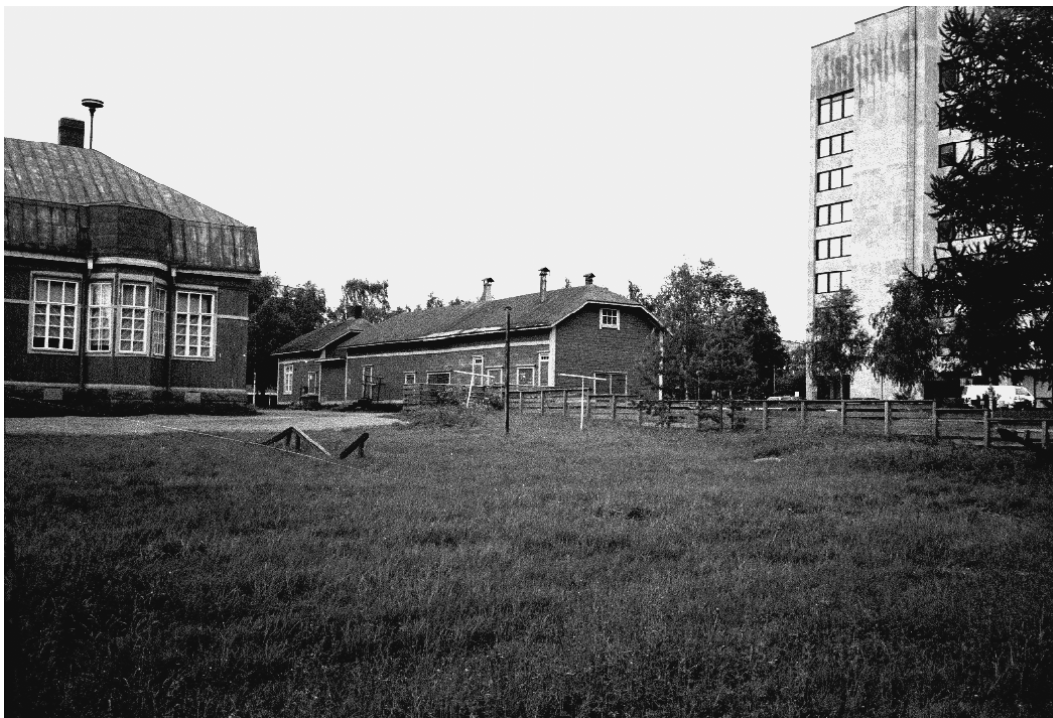
124530: 10. Tornion vanhan kirkon paikka (tontti 00400150021). Kuvassa Porthaninkoulun eteläpäätty (vasemmalla) ja Tornion kaupungintalo (oikealla). Vanha kirkko on sijainnut J. Rinteen mukaan kuvan keskellä koulun ja varastorakennuksen edessä ja osittain niiden alla. Kellotapuli on sijainnut kuvan oikean laidan kohdilla. Kohti E.
