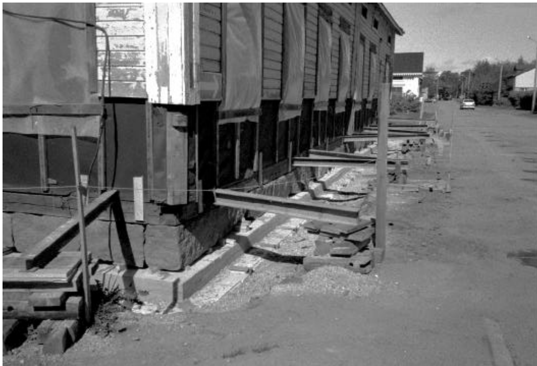
124530: 35. Granrothin talon peruskorjausta. Uusien perustusten tekoa Keskikadun puoleisella sivustalla. Kohti NW.
