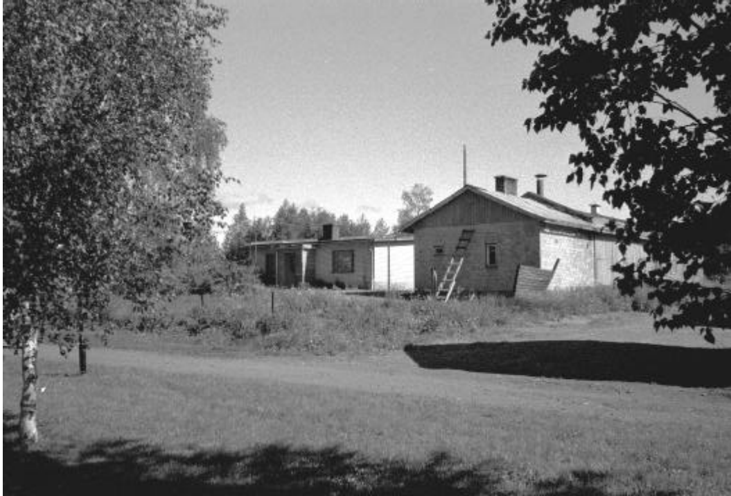
124530: 21. Nymanin talon ja Viippolan talon väliin jäävä tontti (00400020004) kuvattuna puistosta Åströminkadun yli. Etualalla perunapello, taustalla keskellä yksikerroksinen tiilinen asuinrakennus, jonka oikealla puolella tiili- ja puurakenteinen ulkorakennus. Kohti N.
