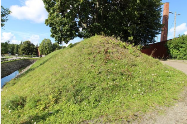
AKDG5378:19. Hämeen linnan 2. puolibastionin vasemman sivun vallihaudan korjausalue ennen kuntan poistoa. Kuvattu kaakosta. Kuvaaja Esa Mikkola.
