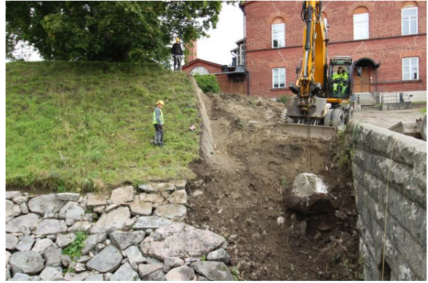
AKDG5378:54. Hämeen linnan 2. puolibastionin vasemman sivun eskarpimuriin kuuluvaa isoa kiveä poistetaan kivisillan vierestä. Kuvattu lounaasta. Kuva Esa Mikkola.
