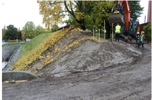
AKDG5378:68. Hämeen linnan 2. puolibastionin vasemman sivun eskarpimuurin ja sen päällisen maavallin korkokepit. Kuvattu kaakosta. Kuva Tuija Väisänen.
