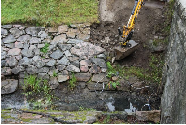
AKDG5378:52. Hämeen linnan 2. puolibastionin vasemman sivun eskarpimuurin uloimpien kivien alla ollutta kiveystä puretaan kaivinkoneella. Kuvattu lounaasta. Kuva Esa Mikkola.
