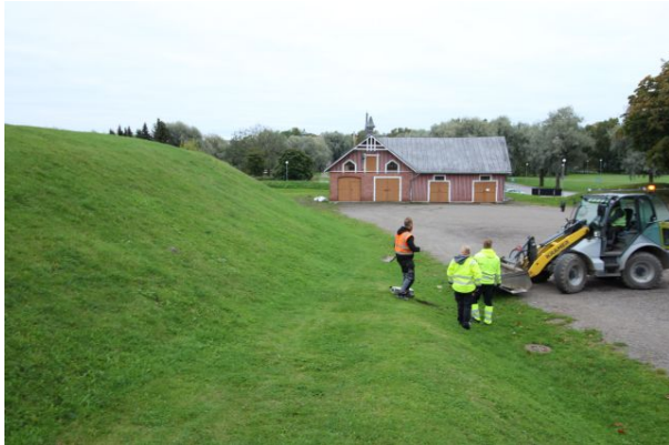
AKDG5378:73. Linnan etupihan itäreunan opastaulun jalustan kuopan kaivun valvonta. Kuvattu luoteesta. Kuvaaja Esa Mikkola.
