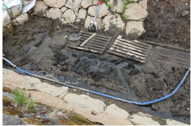
AKDG5378:12. Hämeen linnan 3. puolibastionin eteläpuolen vallihauta, pohjan puurakennetta. Kaakosta. Kuva Tuija Väisänen.
