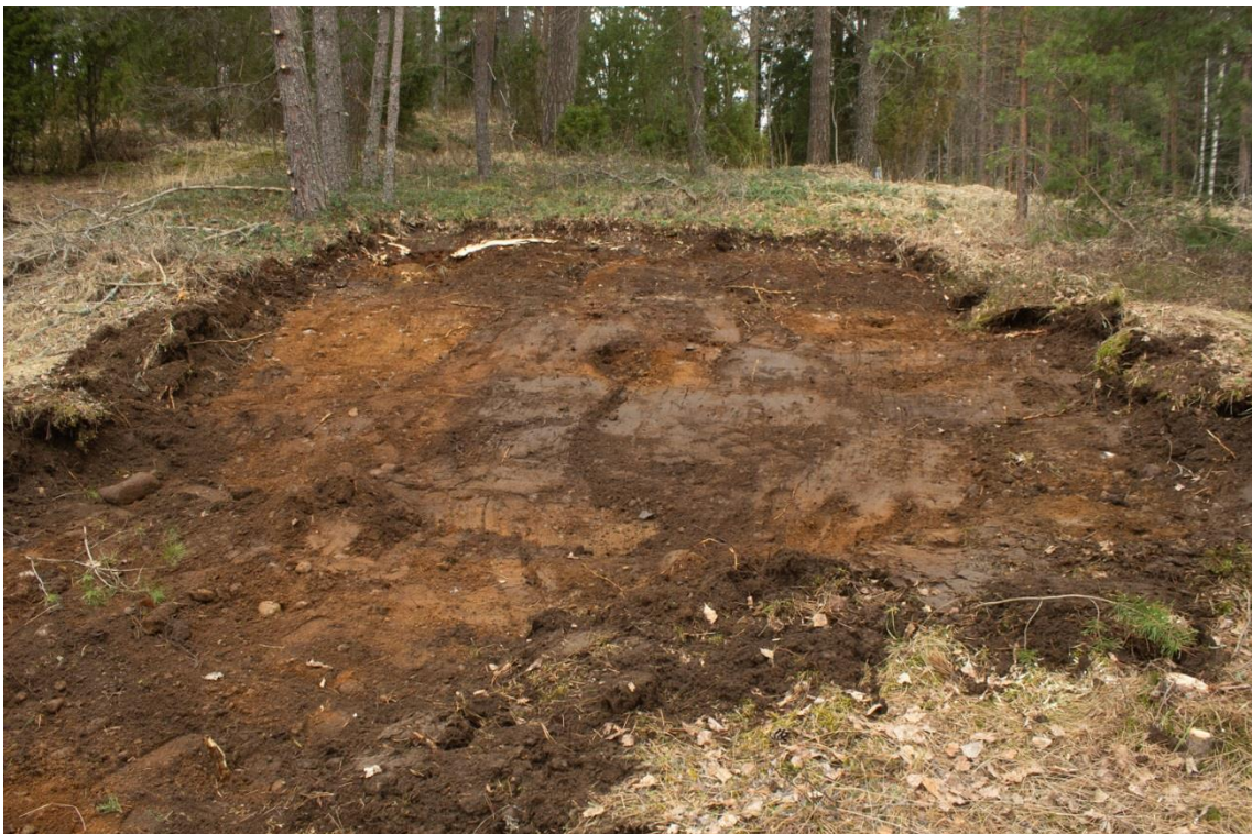
Kuva 4. Puistomuuntamon pohja kaivettu tavoitesyvyteen. Kuvattu kaakosta. Kuva Piritta Häkälä (DIGMAV2018003:8)
