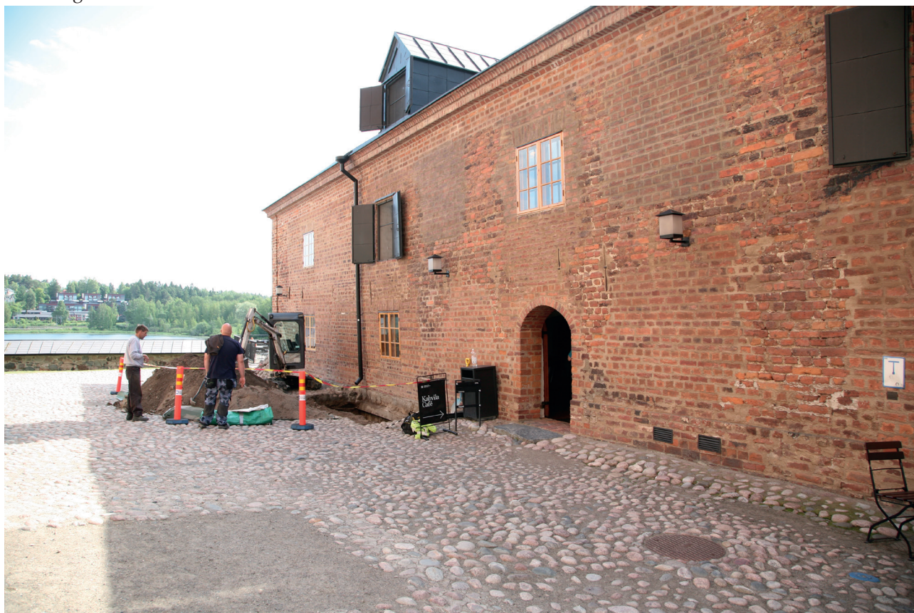
MuTu118018_2. Yleiskuva, kaivannon sijainto. Lännestä. 26.6.2018 Janne Haarala.
