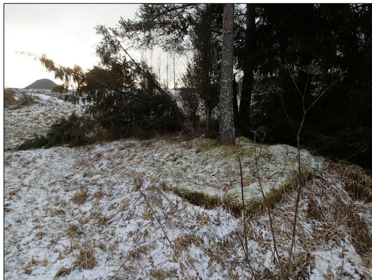
Kuvaussuunta lounaaseen. Pienessä metsäsaarekkeessa sijaitsee eheää kivijalkaa, joka on tehty suorakaiteiksi muotoilluista kivistä.
