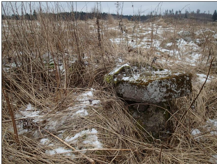
Ainoa kohteella havaittu betoninen jäänne on kuvassa näkyvä suuri harkko.
