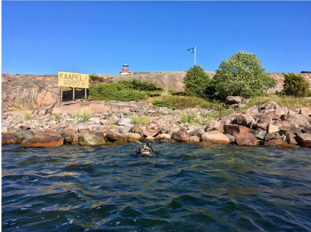
Kuva 7. Uuden kaapelin Gustavsvärnin puoleinen rantautumispiste punaisella merkittynä. Kaapeliliinja kulkee rannasta kohti kuvaajaa. Kuva: Subreering Ammattisukellustyöt Oy.
