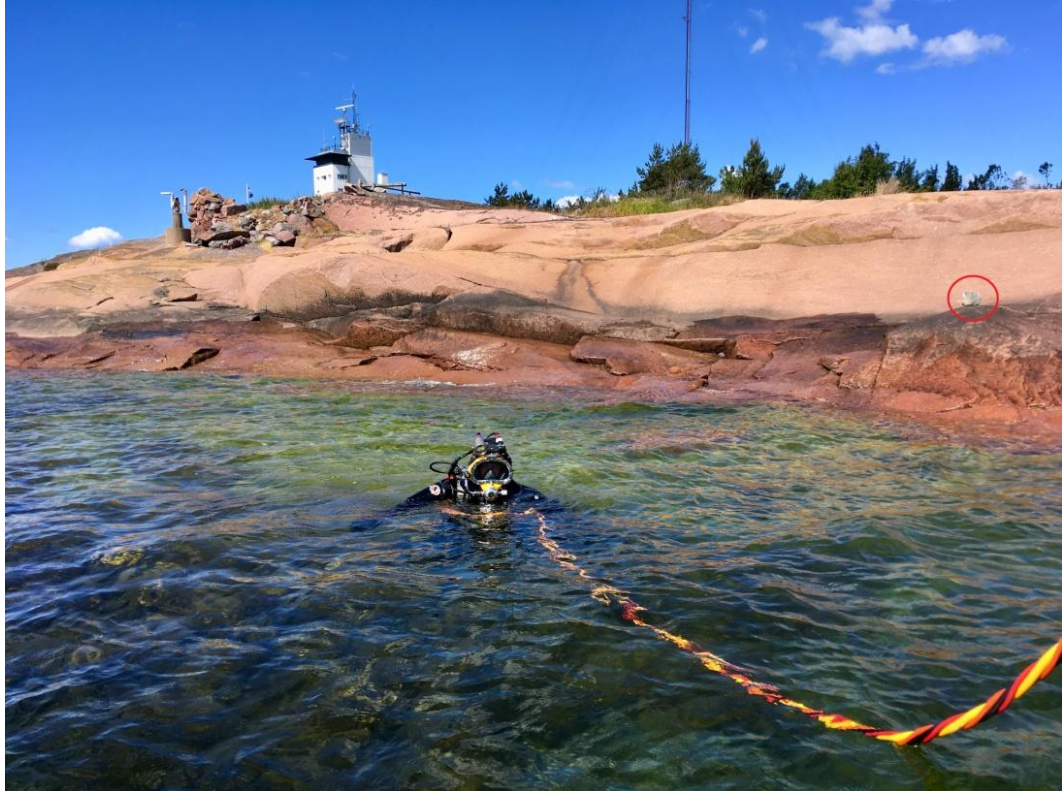
Kuva 8. Uuden kaapelin Tulliniemen puoleinen rantautumispiste punaisella merkittynä. Kaapeliliinja kulkee rannasta kohti kuvaajaa. Kuva: Subreering Ammattisukellustyöt Oy.
