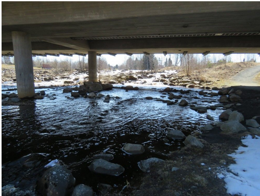
Padon kohta kuvattu Koskenalantien sillan pohjoispuolelta etelään.
