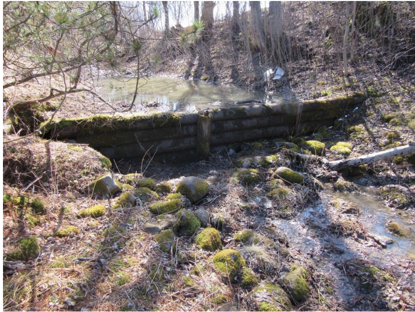
Toiseksi eteläisin pato lounaaseen.
