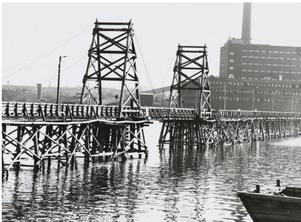
Kuva 2. Lauttasaaren väliaikainen silta vuonna 1969. Silta oli ns. läppäsilta, jotta esim. suuremmat kivihiililastissa olevat alukset pääsivät kuljettamaan lastia Salmisaaren voimalaan (taustalla). ©J.Aarnio / Museoviraston kuvakokoelmat / Historian kuvakokoelma.
