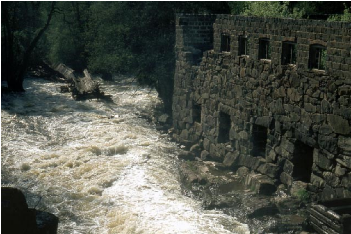
Mylly purkamisen jälkeen vuonna 1981 joen tulviessa. Oikeassa alakulmassa näkyy vielä puukourua tukenut hirsiaarkku. (Kuva Finna / E. Härö, Museovirasto M012 RHO18596)
