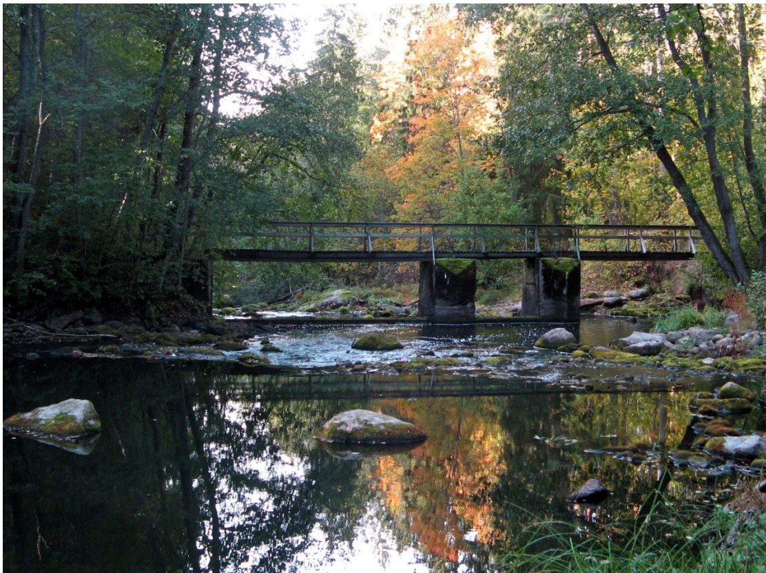
SKDG201809:25 Ruukin pato- ja siltarakenne idästä.
