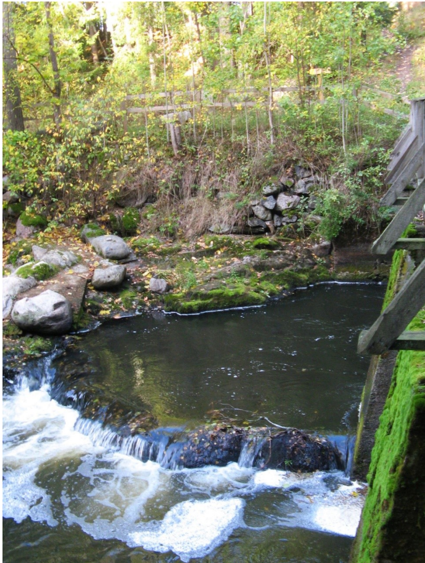
SKDG201809: Ruukin padolle/sillalle ulottuva kivirakenne.
