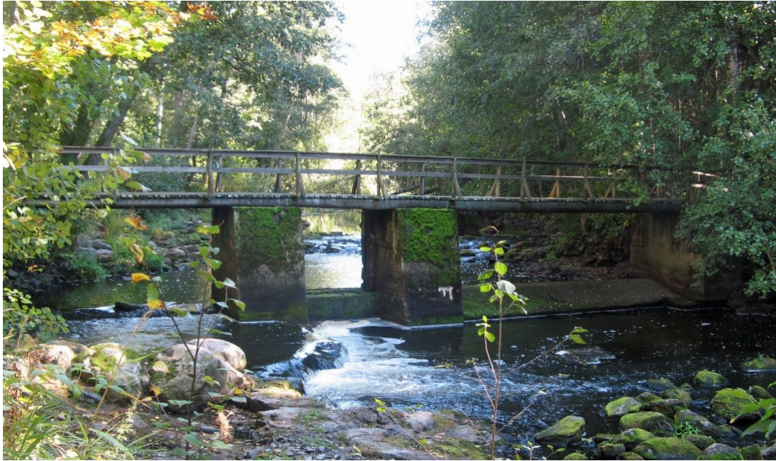
SKDG201809:21 Ruukin itäpuolen pato- ja siltarakenne lännestä.
