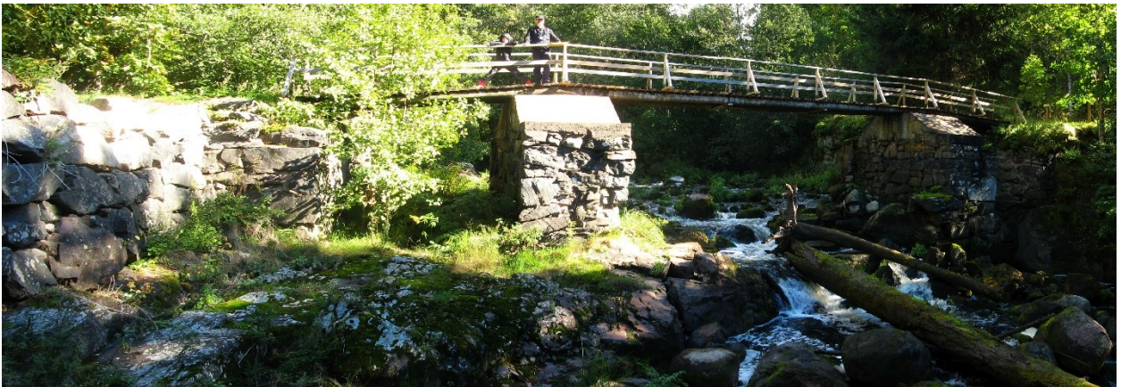
SKDG201809:12 Nykyinen silta, jonka alla on kivrakenteita.
