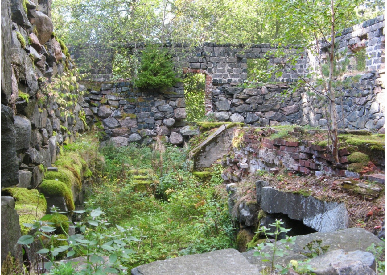
SKDG201809:8 Myllynraunio sisäpuolelta, idästä. Tässä rakennuksen eteläosassa on nähtävästi ollut vesiratas.
