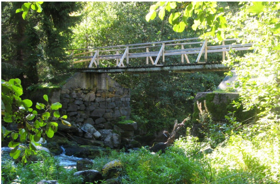
SKDG201809:41 Kivirakennetta joen etelärannalla, myllyn itäpuolella kulkevan sillan alla.
