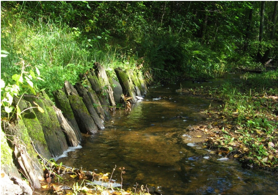
SKDG201809:2 Paalurivistöä uoman länsiosan pohjoisreunassa.
