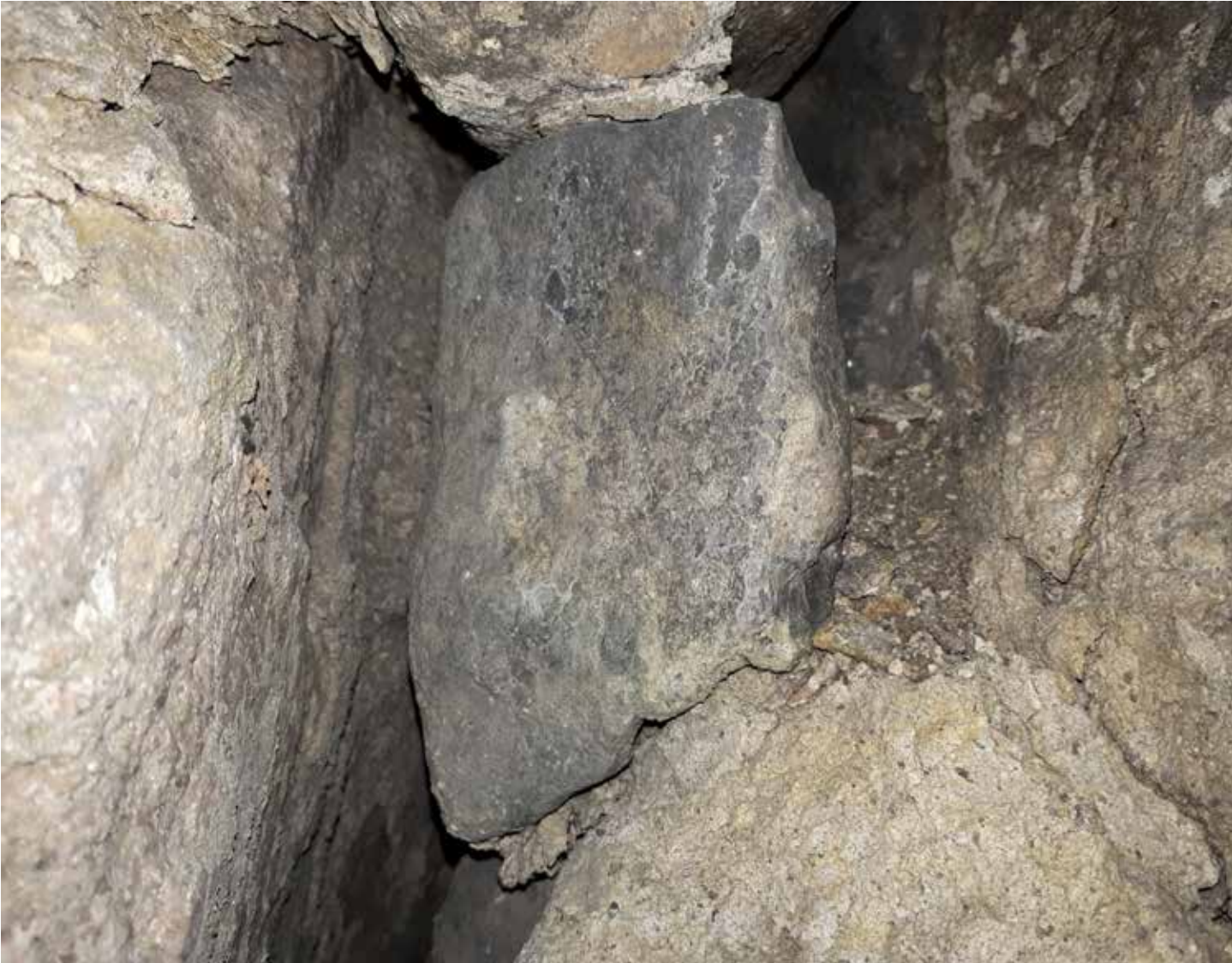
Kuva 4. MuTu218001:4. Telinetaso 2. keskiosa nro 11. Kolmiomainen muurin avausaukko, josta havaittiin multamaata. Aukon pohjalta tuli esiin n. 50-55 cm:n syvyydeltä vanhempi muurirakenne. Kuvassa vasemmalla vanhempi muuripinta, keskellä kuvaa irtonaisessa laastissa oleva kivi ja oikealla pintamuurauskiven taustaosa. KU. Joulukuu 2017. W
