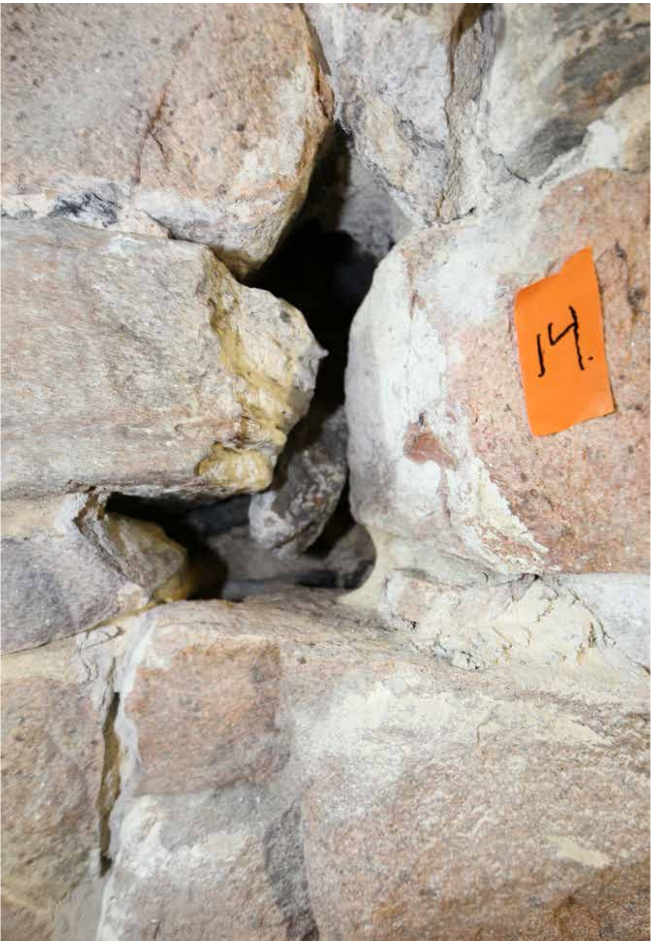
Kuva 5. MuTu218001:6. Telinetaso 2. keskiosa nro 14. Kaksiosainen muurin avausaukko, josta havaittiin multamaata. Aukon pohjalta tuli esiin n. 45-50 cm:n syvyydeltä vanhempi muurirakenne. KU. Joulukuu 2017. W
