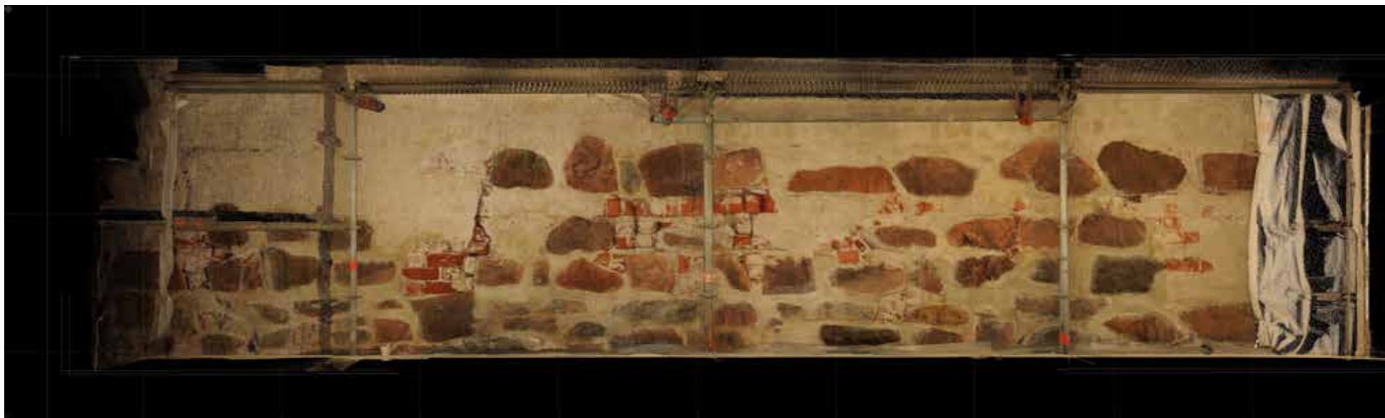
Karttakuva 2. Telinetaso 7. syksy 2017. Alakuvassa punainen alue on yli 25 cm:n syvyydellä muurirakenteen pinnasta.
