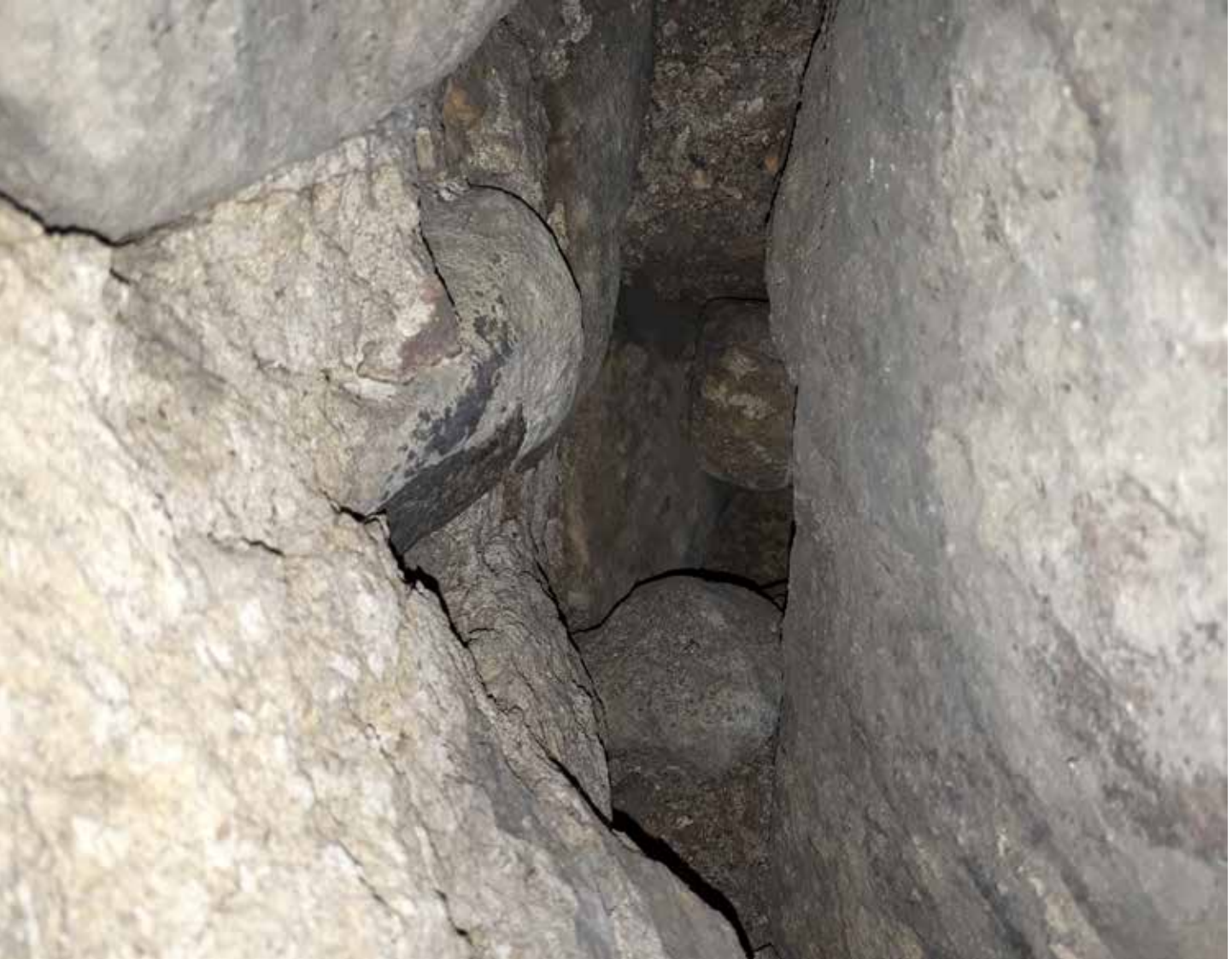
Kuva 5. MuTu218001:5. Telinetaso 2. keskiosa nro 11. Kolmiomainen muurin avausaukko, josta havaittiin multamaata. Aukon pohjalta tuli esiin n. 50-55 cm:n syvyydeltä vanhempi muurirakenne. Kuvassa oikealla vanhempi muuripinta, keskellä kuvaa puhdistettu halkeama ja vasemmalla pintamuurauskiven taustaosa. Kuvan taustalla näkyy saumauksen täyttömateriaali. KU. Joulukuu 2017. W
