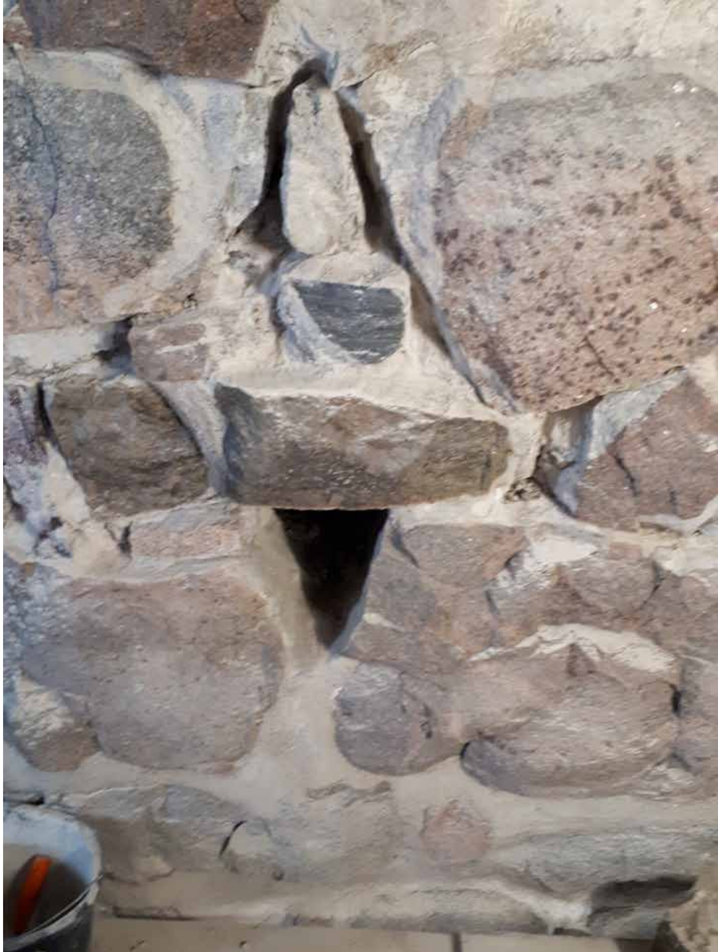
Kuva 1. MuTu218001:1. Telinetaso 2. keskiosa nro 11. Kolmiomainen muurin avausaukko, josta havaittiin multamaata. Aukon pohjalta tuli esiin n. 50-55 cm:n syvyydeltä vanhempi muurirakenne. KU. Joulukuu 2017. W
