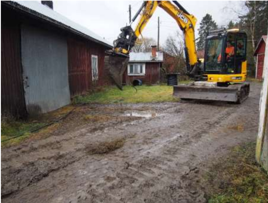
Kuva 5. Maakaapelilinjausta ryhdytään kaivamaan Linnanen historiallisella kylänpaikalla. Kuvattu kaakosta. (Kuva: Valkeakoski Linnanen 2017:1)
