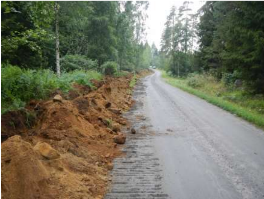
Kuva 6. Valvottua kaapelikaivantoa Härmäntien eteläreunassa. Kuvattu idästä. (Kuva: Ujala, Vesaniemi ja Neittenlinna 2017:2)
