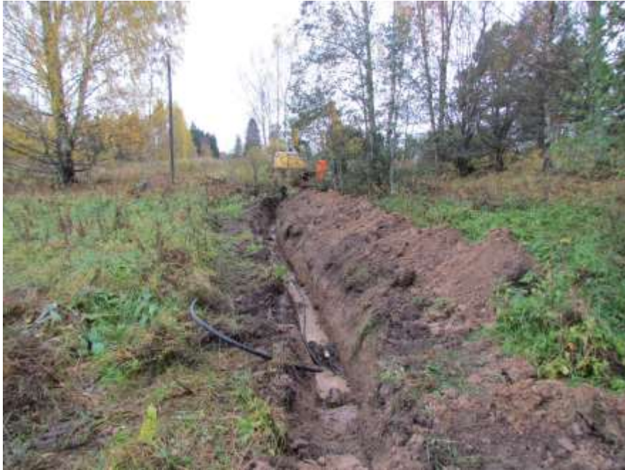
Kuva 11. Valvotun kaapelilinjauksen pohjoisosaa. Kuvattu pohjoisesta. (Kuva: Urjala, Vesaniemi ja Neittenlinna 2017:6)
