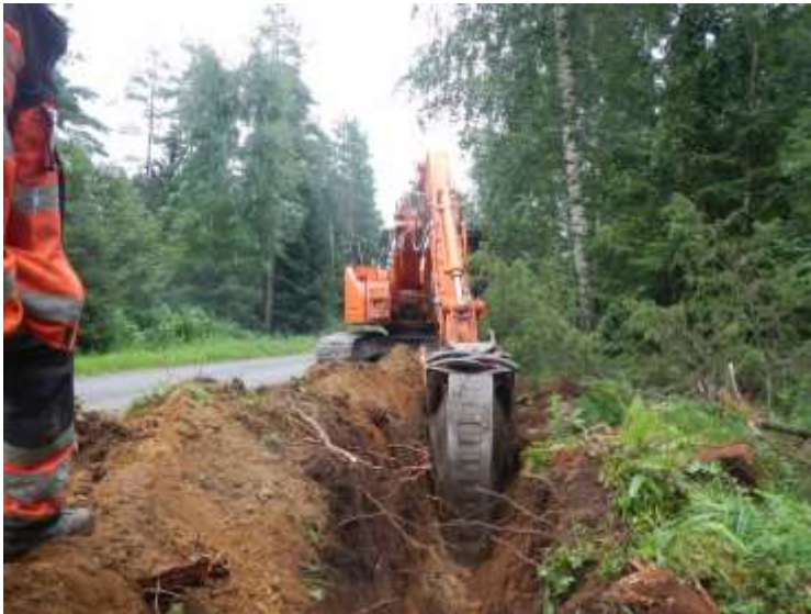
Kuva 4. Maakaapelilinjaa kaivetaan Urjalan Neittenlinnan muinaisjäännösalueen eteläpuolella. Kuvattu lännestä. (Kuva: Urjala, Vesaniemi ja Neittenlinna 2017:1)
