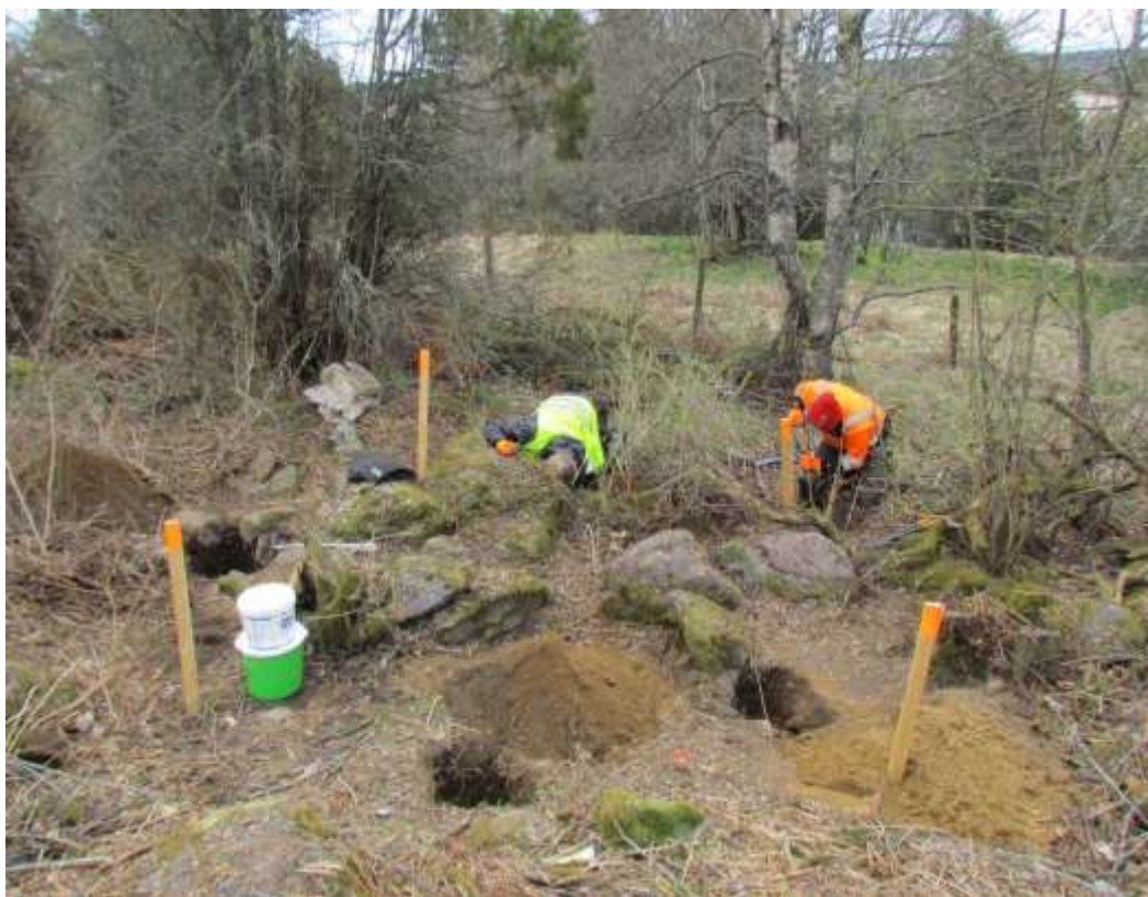
Kuva 7. Puistomuuntamon paikalle, kivien väliin kaivetaan koekuoppia. Kuvattu pohjoisesta. (Kuva: Urjala Ali-Uotila 2017:5)
