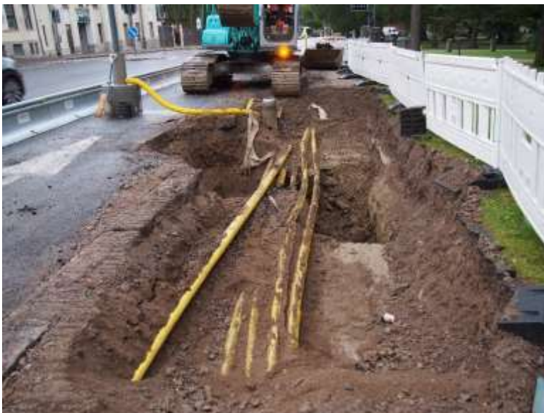
Kuva 13. Alue 2 kaivettuna pohjaan. Kuvattu lännestä. (Kuva: Tampere Pyynikin kirkkokuisto 2017: 8)
