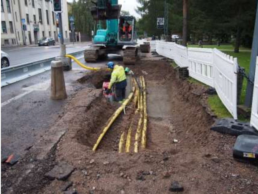
Kuva 5. Kaivuuta Pirkankadun varressa. Kuvattu lännestä. (Kuva: Tampere Pyynikin kirkkopuisto 2017:1)
