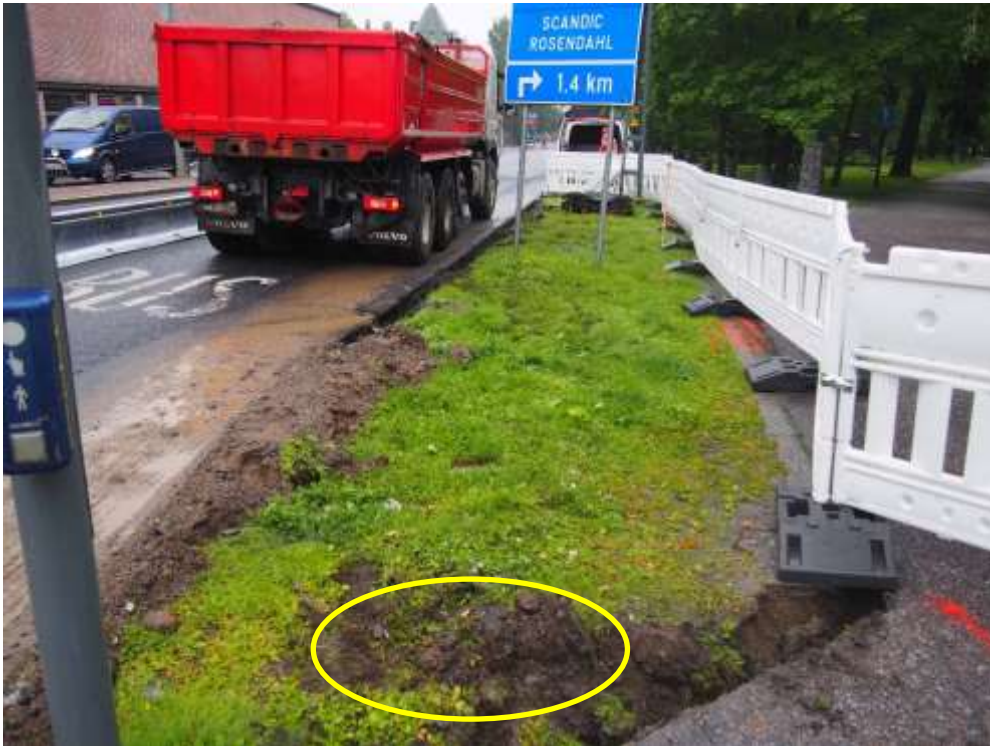
Kuva 10. Havaintokohta B ennen kaivuuta (merkitty keltaisella nuolella). Kuvattu lännestä. (Kuva: Tampere Pyynikin kirkkokuisto 2017: 5)
