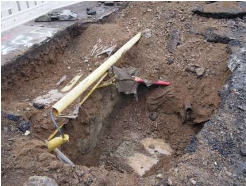
Kuva 14. Alue 3 kaivettuna pohjaan. Kuvattu koillisesta. (Kuva: Tampere Pyynikin kirkkokuisto 2017: 9)
