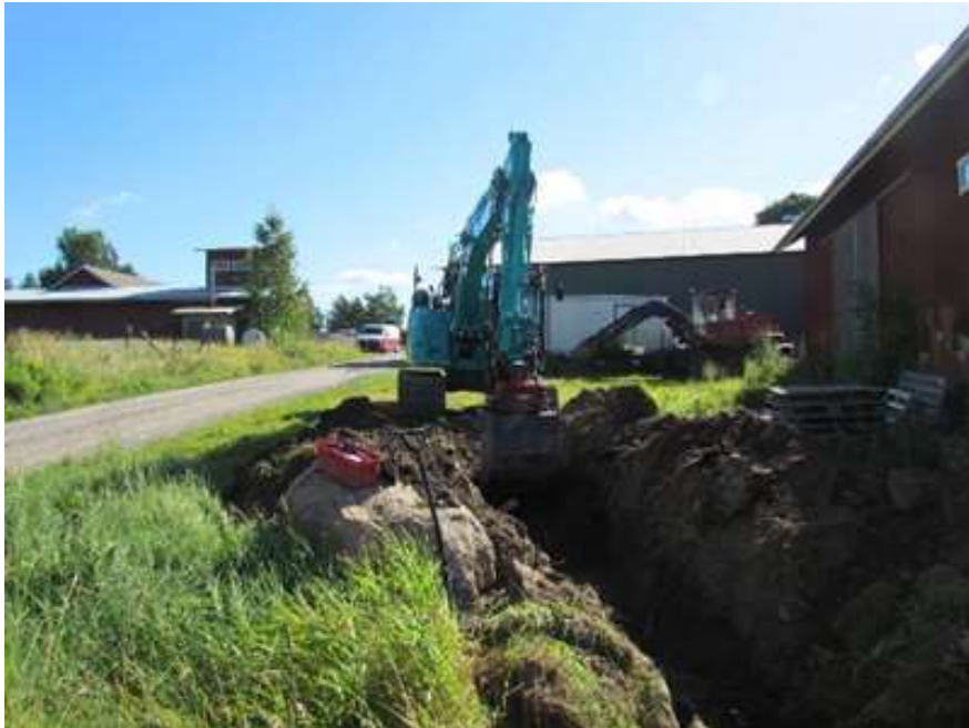
Kuva 3. Maakaapelilinjausta kaivetaan Arven tilan ulkorakennuksen pihamaalla. Kuvattu lännestä. (Kuva: Sastamala Kirkkovainio 2017:1)
