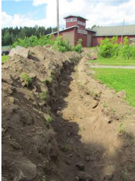
Kuva 8. Maakaapelikaivantoa Arven tilan päärakennuksen pohjoispuolisella pihamaalla. Kuvattu etelästä. (Kuva: Sastamala Kirkkovainio 2017:6)
