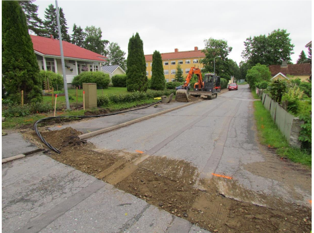
Kuva 5. valvonta-alueen eteläosassa kaapeli asennettiin kestopäällystetyn tien kohdalle.
