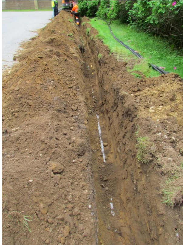
Kuva 6. Kaapelikaivannon kohdalle koulun länsipuolelle oli aiemmin kaivettu kaapeleita, joiden päälle uusi kaapeli asennettiin. Maakerrokset olivat sekoittuneita.
