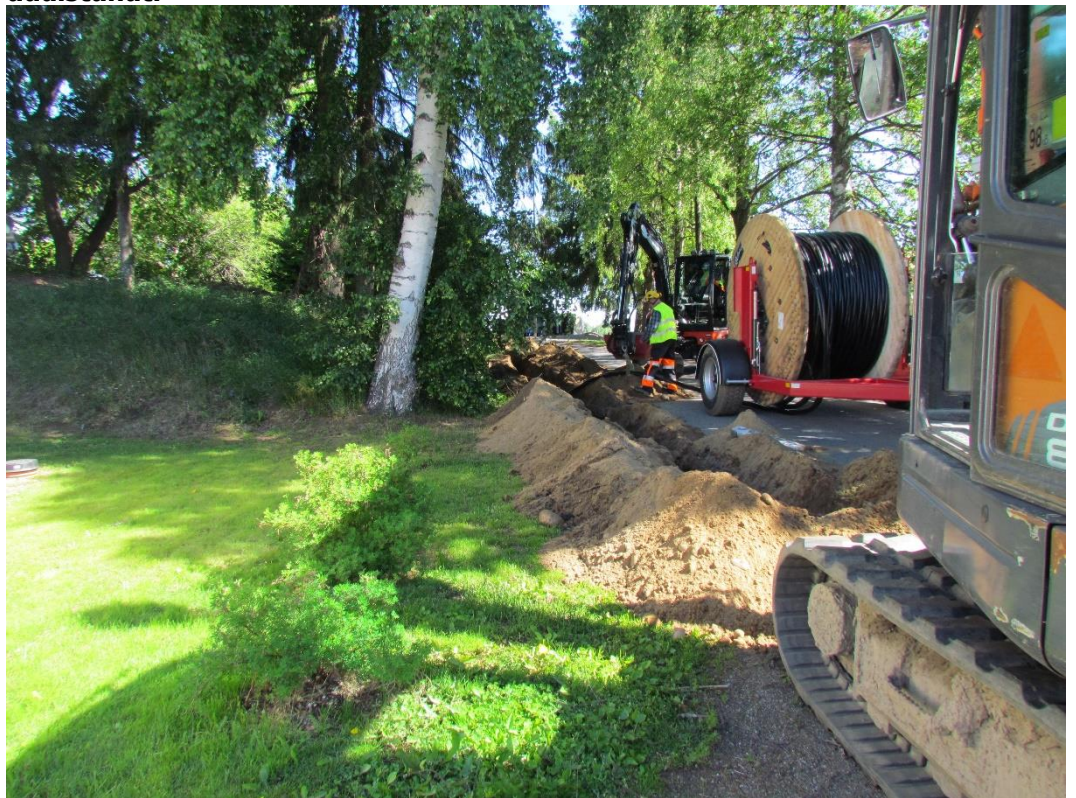
Kuva 4. Kaapelin asentaminen tapahtui välittömästi kaivamisen jälkeen.
