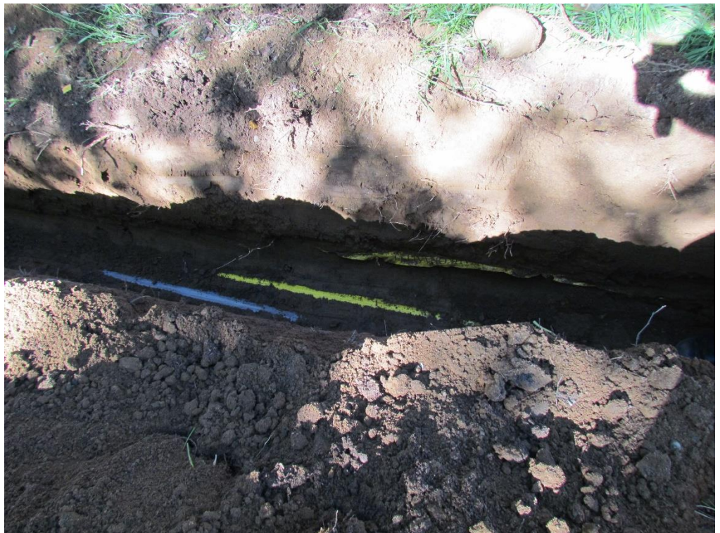
Kuva 7. Aiemmin asennettuja kaapeleita ns. Lofroosin talon (katso kuva 2) kohdalla.
