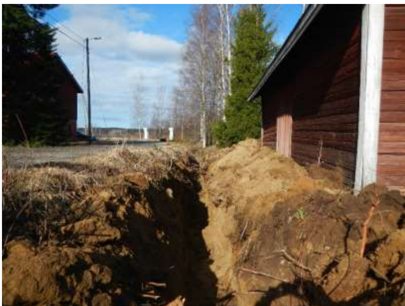
Kuva 7. Onnistaipaleentien vieressä maakaapelilinjaus kulki tien pohjoisreunassa, ojassa. Kuvattu idästä. (Kuva: Orivesi Onnistaipale 2017:1)
