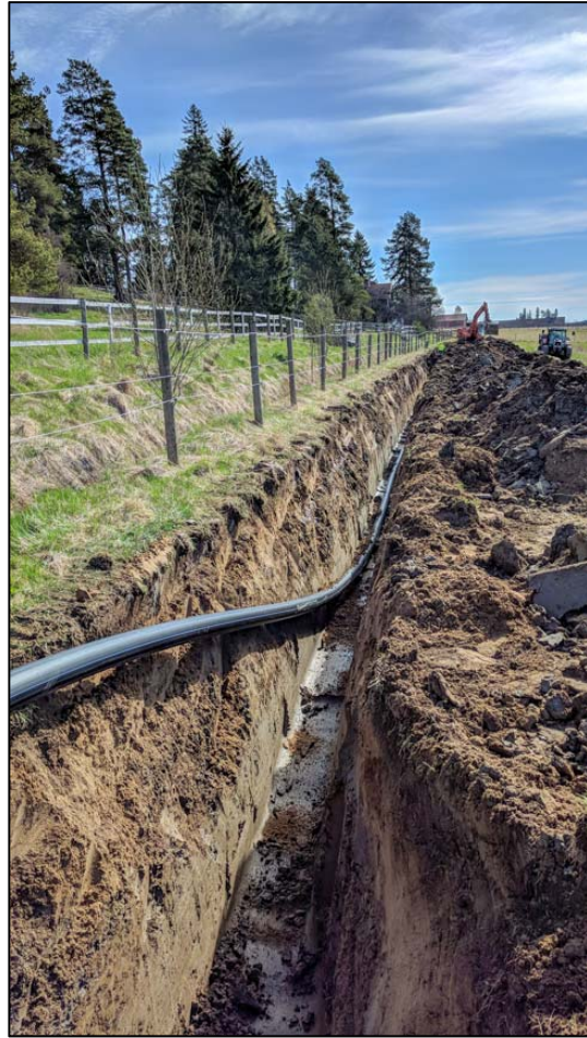
Kuva 19. Vesijohtokaivantoa linjan länsipäässä. (AKDG5601:12)
