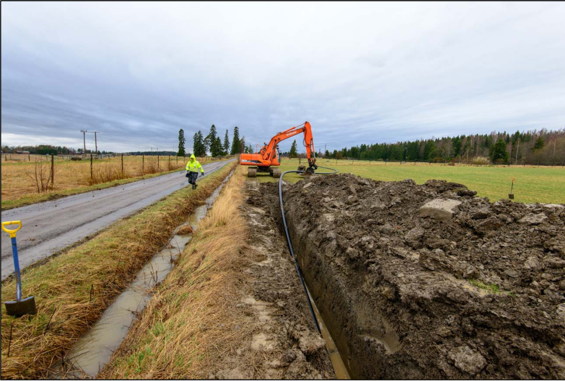
Kuva 10. Vesijohtokaivantoa Karrinmäentien varressa. Kuva idästä. (AKDG5601:1)
