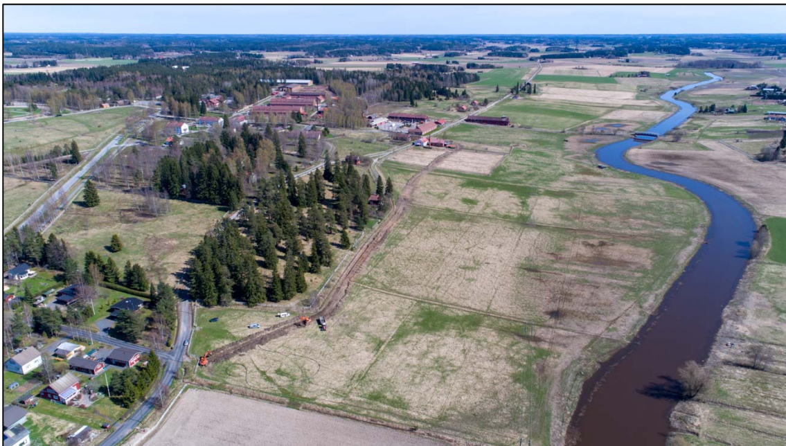
Kuva 20. Vesijohtokaivannon valvottu osuus kaivettuna pellolla Hevosopiston länsipuolella. Kuvauskohterin kuva lännestä. AKDG5601:18
