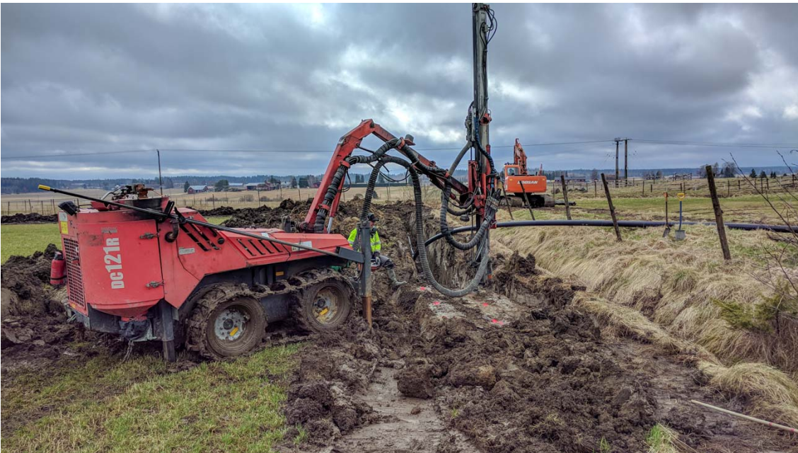
Kuva 11. AKDG5601:8 Kiveä porataan räjäytystä varten vesijohtokaivannossa Karrinmäentien varressa. Kuva pohjoisesta.
