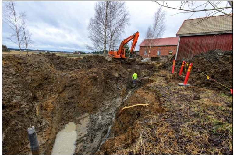
Kuva 12. Vesijohdon liittymän kohtaa kaivetaan Hevosopiston kohdalla. Kuva pohjoisesta. (AKDG5601:3)
