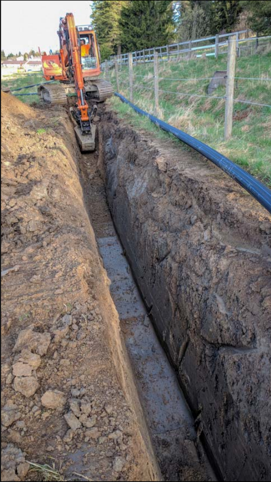
Kuva 18. Vesijohtokaivantoa Hevosopiston länsipuolella. AKDG5601:11)
