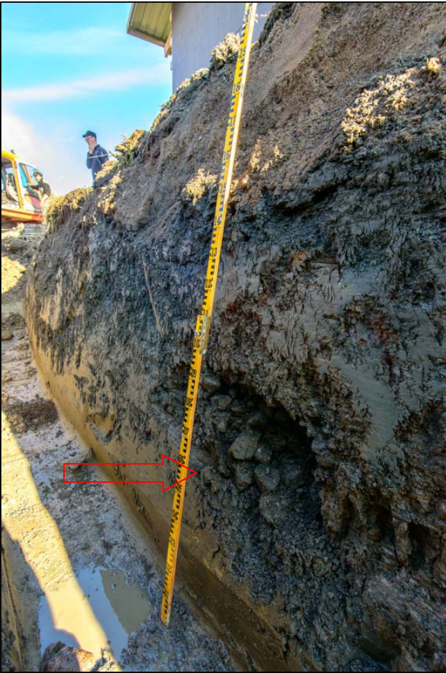
Kuva 17. Mukulakivistä tehty vanha salaoja vesijohtokaivannon leikkauksessa. Kuva idästä. (AKDG5601:6)
