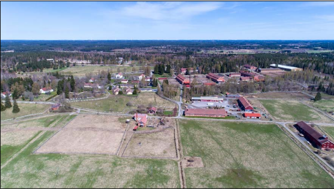
Kuva 3. Kartanonkylä/Kartano historiallinen asuinpaikka sijaitsee vesijohtokaivannon pohjoispuolella. Kuvauskopterin kuva etelästä. (AKDG5601:20)
