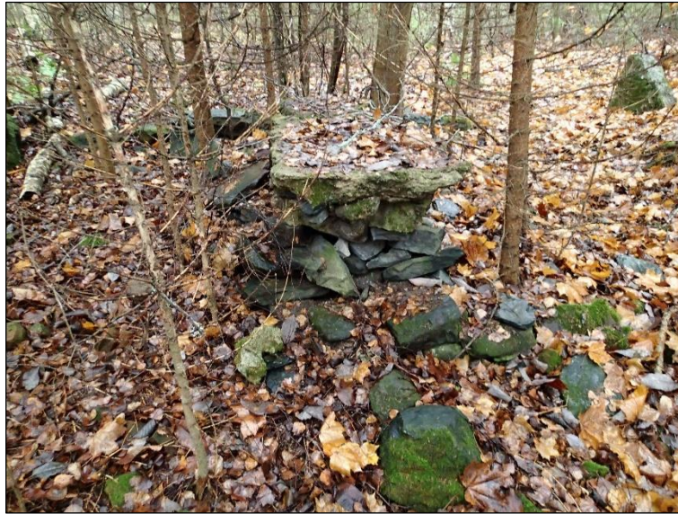
Rakennuksen perustus (kartalla nro 3). Koilliseen.
