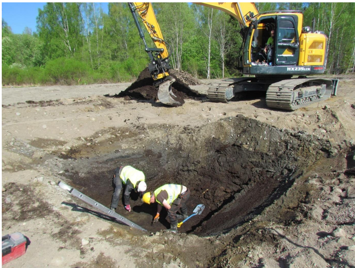
Kuva 3. Kaivannon pintakerrokset koostuivat varikonaikaisesta täyttösorasta, minkä alapuolella sijaitsevaa turvekerrosta havainnottiin.
