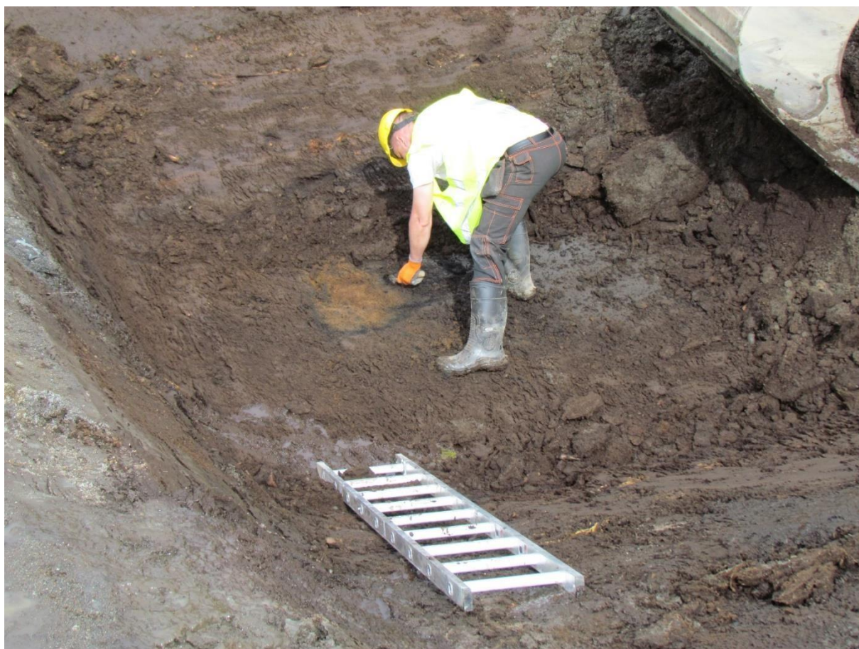
Kuva 4. Konekaivuun yhteydessä havaitut ilmiöt kaivettiin käsityökaluilla.
