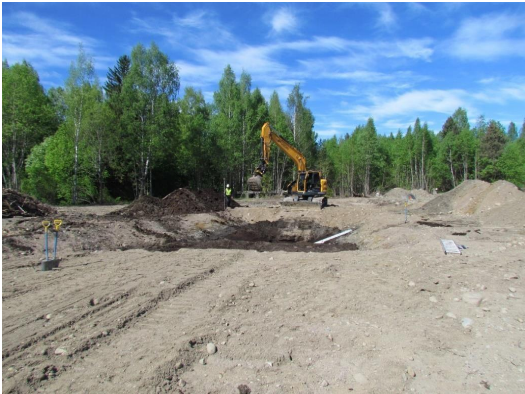
Kuva 1. Alueelta poistettiin keväällä 2017 kasvillisuus ja varikkorakennusten perustukset.
