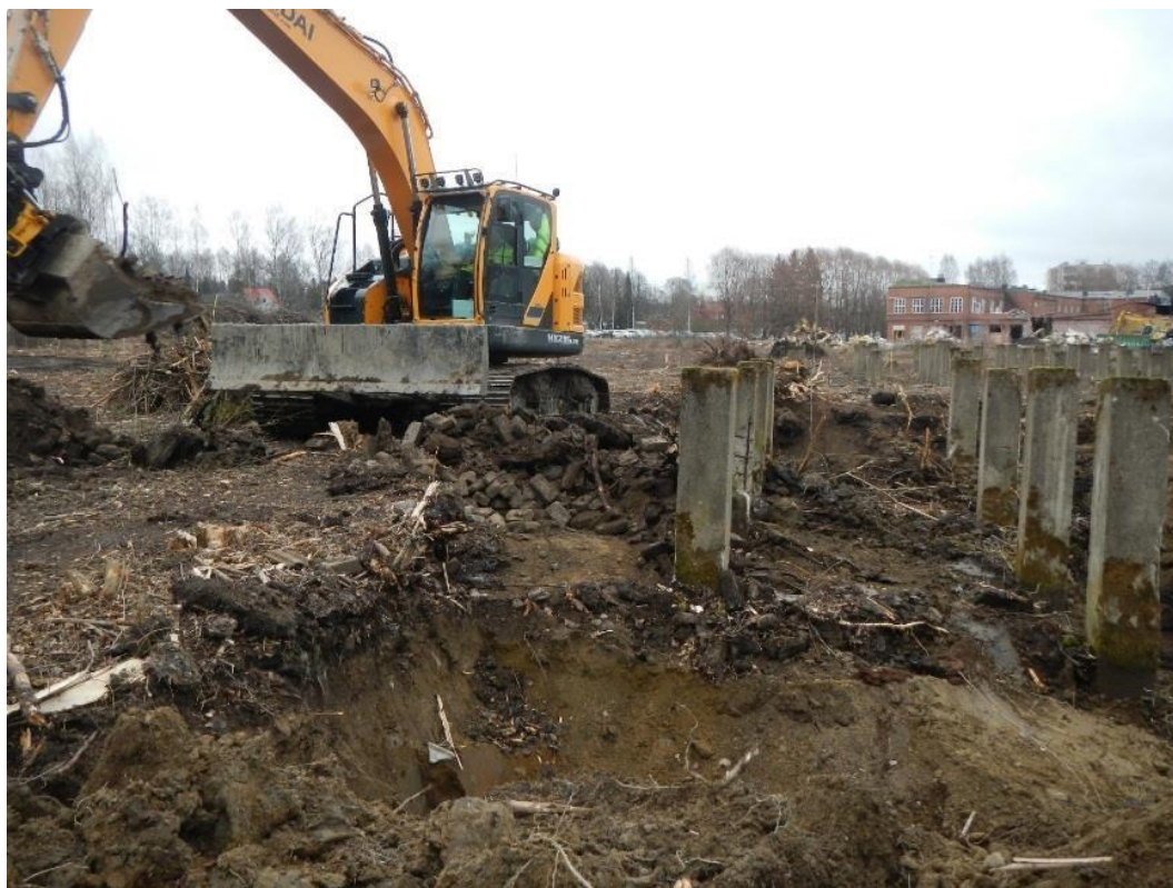
Kuva 1. Valvonnan yhteydessä työalueelta poistettiin koneellisesti armeijan elintarvikevarikon rakennusten betonipilareita. Kuva 20.3.2017
