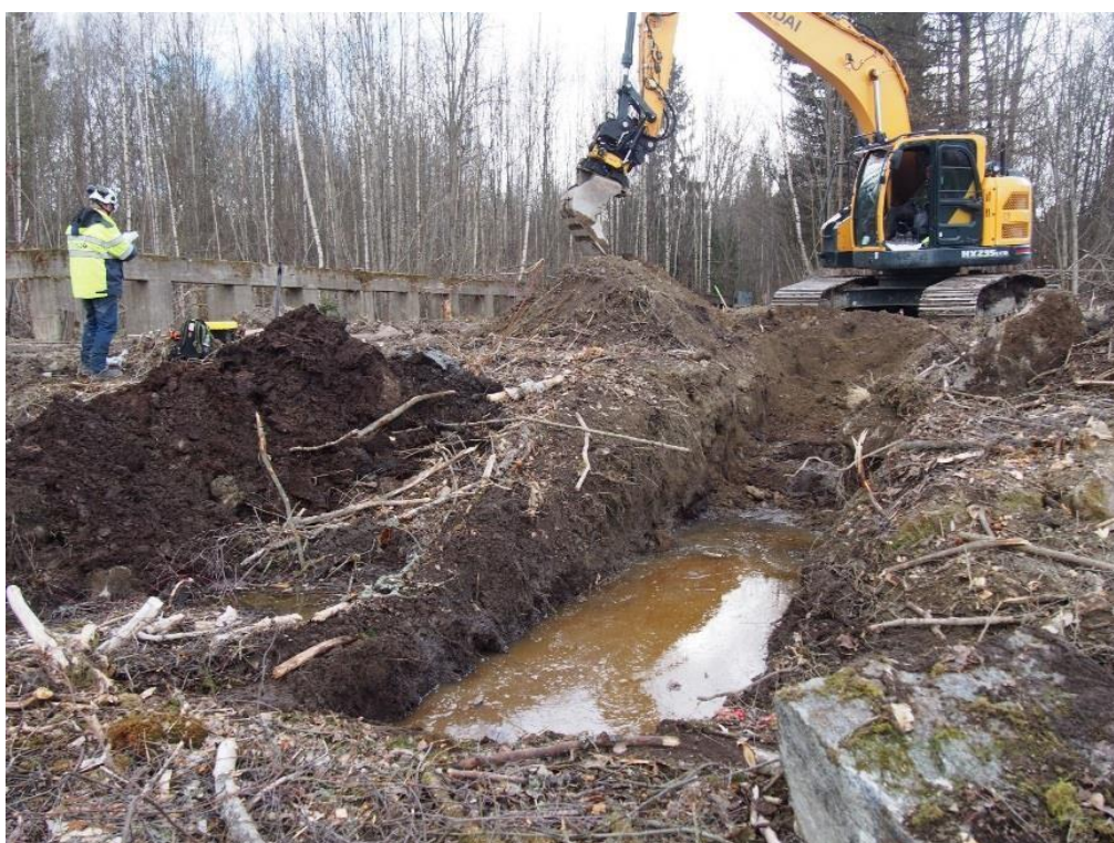
Kuva 11. Koekuoppa 13 kaivettiin täyttömaan läpi turpeen pintaan 9 metriä pitkänä kaivantona.
