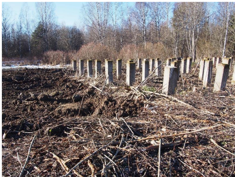
Kuva 3. Työpäivän päätteeksi kaivanto täytettiin 16.3.2017.
