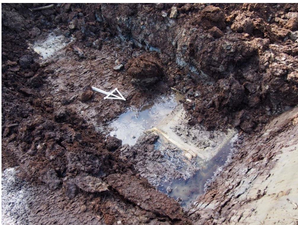
Kuva 4. Maannosta anturoiden välissä (pohjoiseen osoittavan nuolen kohdalla). Maakerrokset ovat melko sekoittuneita alle 1 metrin syvyydessä maanpinnasta. 20.3.2017.
