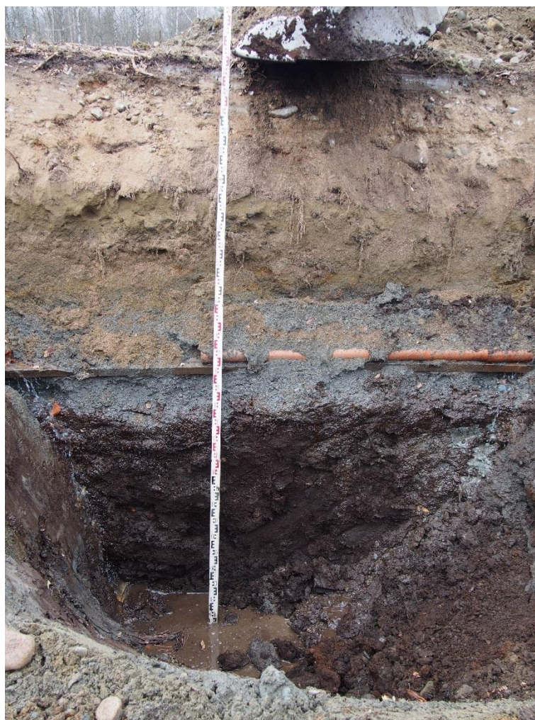
Kuva 10. Savinen pohjamaa tuli vastaan noin 3,3 metrin syvyydessä Varastorakennuksen 2 länsireunan keskivaiheilla. Ratapohjan täyttösoraa on noin 1,5 metriä. Turvekerros oli paksuudeltaan noin 1,5 metriä.
