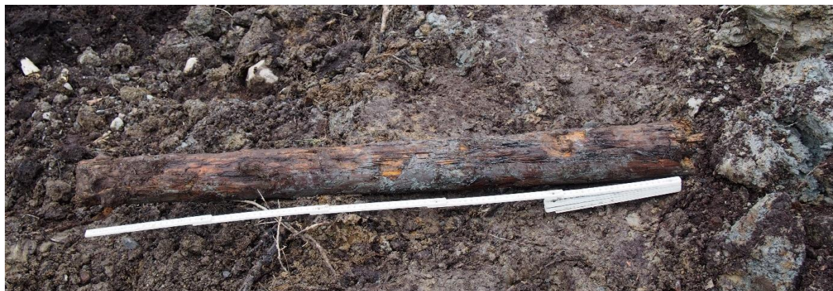
Kuva 7. Tämä puupaalu löydettiin varaston 2 perustuksia kaivettaessa 4.4.2017.
