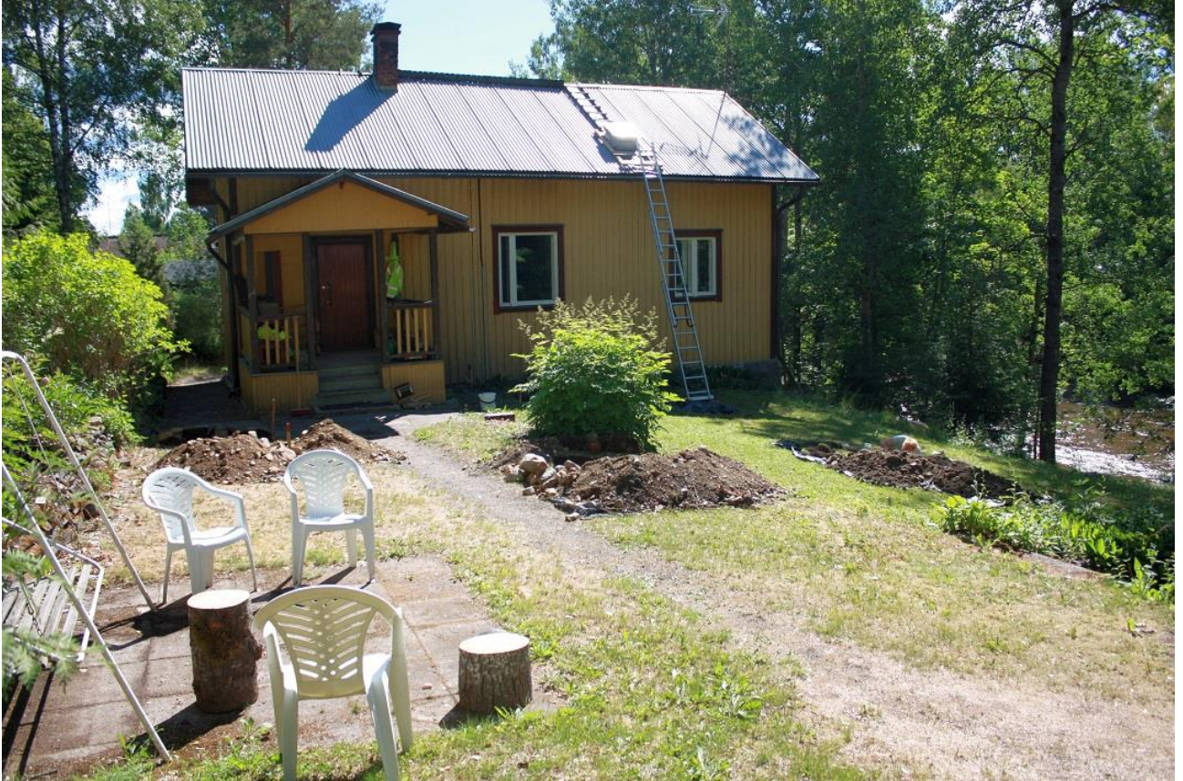
Kuva 2. Asuinrakennus ja läntinen piha-alue. Laajennusosan rakennusala kuvassa oikealla puutarhatuolien takana. Kuokkalankoski kuvassa oikealla. AKDG 5616:4.
