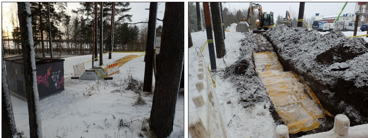
Vasen: muuntamokopin länsipuolella (kuvassa oikealla puolella) näkyy kaksi säteilylämmittintä sekä routamatot, jotka sulattivat jäisen maan ennen tutkimuksia. Lounaaseen. Oikea: routamatot pitivät avatun kaivannon sulana öisin. Länteen.
