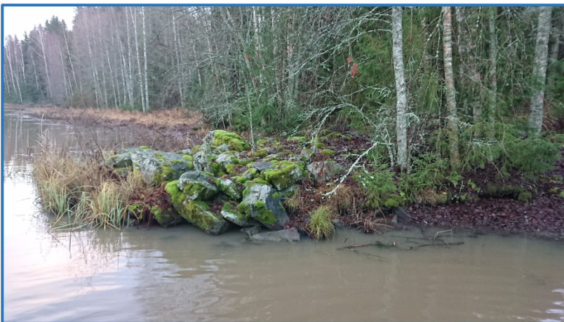
Kuva 8. Vanhan sillan perustuksia joen etelärannalla.
