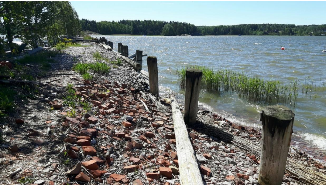
Kuva 3. Lastauslaiturin länsipuoli. Näkymä kohti etelää. Kuva: Rami Kokko.
