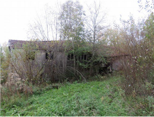
Saha-/myllyrakennus kuvattu luoteeseen.
