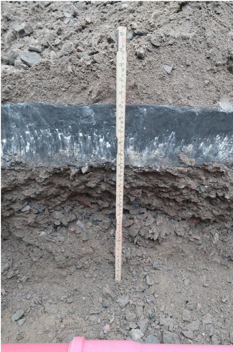
Kuva 10. HP1 lähempää. Asfaltin alla on sora ja karkea hiekka. Kuvaussuunta N. Kuva Heini Hämäläinen/HKM 20.11.2019.
