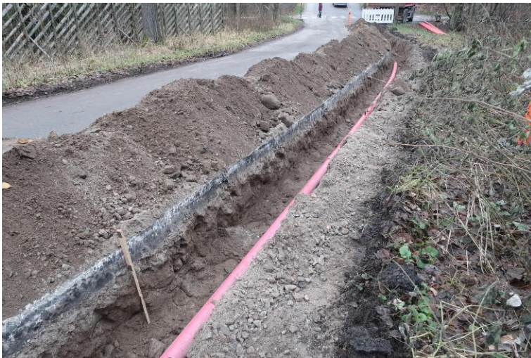
Kuva 11. Kaivuu on edennyt jo hieman lännemmäksi. Kaapeli tullaan asentamaan pinkkiin putkeen, joka heti asennuksen jälkeen peitettiin. HP2 itään päin kuvattuna. Kuva Heini Hämäläinen/HKM 20.11.2019.
