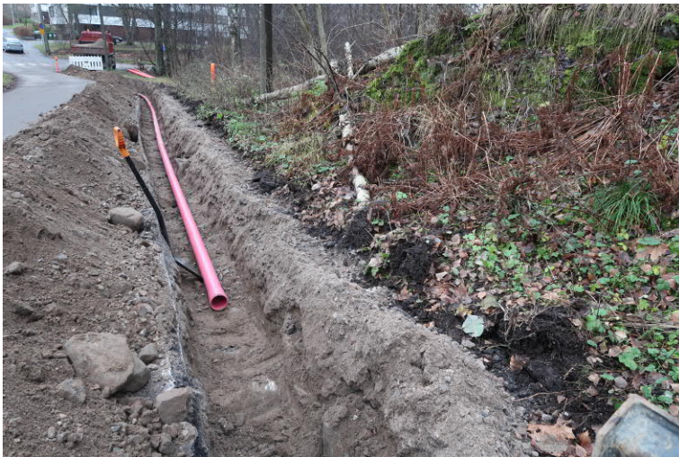
Kuva 13. Kaivantoa suojahuoneen kummun kohdalla. Kaivannossa edelleen vain täyttösoraa ja hiekkaa. Kuvaussuunta E. Kuva Heini Hämäläinen/HKM 20.11.2019.
