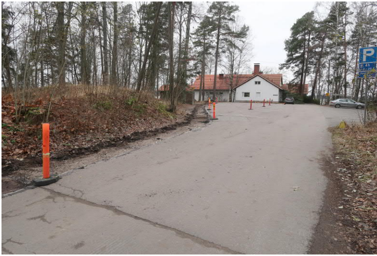
Kuva 27. Asfaltti on poistettu kohdasta missä Vaskiniementie kulkee rintasuojan läpi. Kuvaussuunta W. Kuva Heini Hämäläinen/HKM 21.11.2019.
