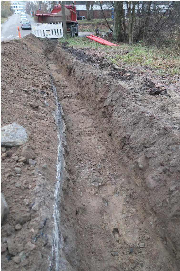
Kuva 7. Kaivannon alkupäätä itään katsottuna, paremmin näkyvissä eteläprofiili. Profiilissa ei näy linnoitteeseen liittyviä rakenteita. Kuvaussuunta E. Kuva Heini Hämäläinen/HKM 20.11.2019.
