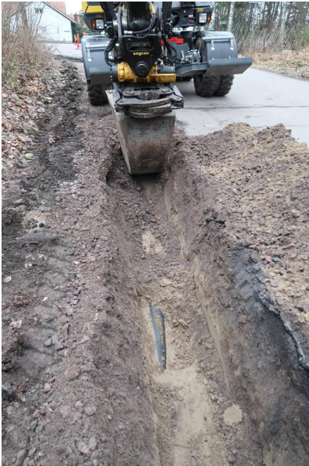
Kuva 31. Kaivinkone kaivaa kaukolämpöputken selkää pitkin. Putki ei ole kovin syvällä, mutta kuitukaapeli mahtui sen päälle kuitenkin. Kuvaussuunta W. Kuva Heini Hämäläinen/HKM 21.11.2019.
