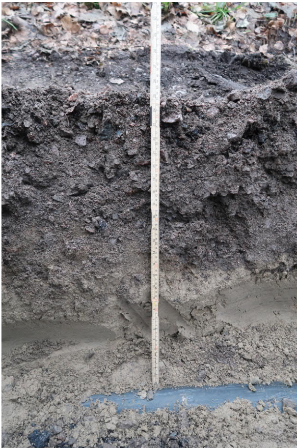
Kuva 32. Eteläprofiilia kaukolämpöputken kohdalla, HP7. Kuvaussuunta S. Kuva Heini Hämäläinen/HKM 21.11.2019.
