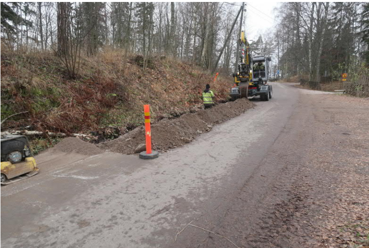
Kuva 15. Uusi putki idempänä on jo peitetty ja kaivuu jatkuu suoja- huoneen kummun kohdalla länttä kohti. Kuvaussuunta W. Kuva Heini Hämäläinen/HKM 20.11.2019.
