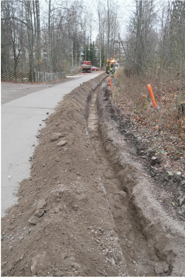
Kuva 33. Kaivuu on edennyt rintasuojan ohi. Kuvaussuunta E. Kuva Heini Hämäläinen/HKM 21.11.2019.
