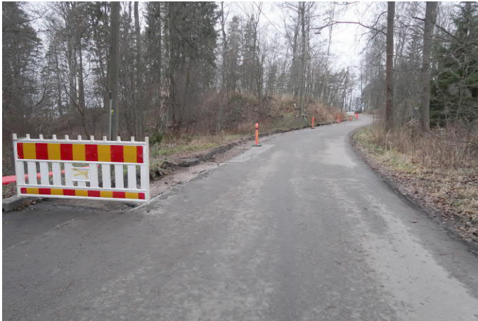
Kuva 1. Valvonta alkaa Vaskiniemessä aamulla 20.11.2019. Asfaltti on jo poistettu kuitukaapelin asennuskohdasta Vaskiniementien etelälaidalta runsaan puolen metrin leveydeltä. Taustalla oleva kumpare on kookas suojuhuone linnoitteen rintasuojan taustalla eli itäpuolella (mantereen puolella) Kuvaussuunta W. Kuva Heini Hämäläinen/HKM 20.11.2019.
