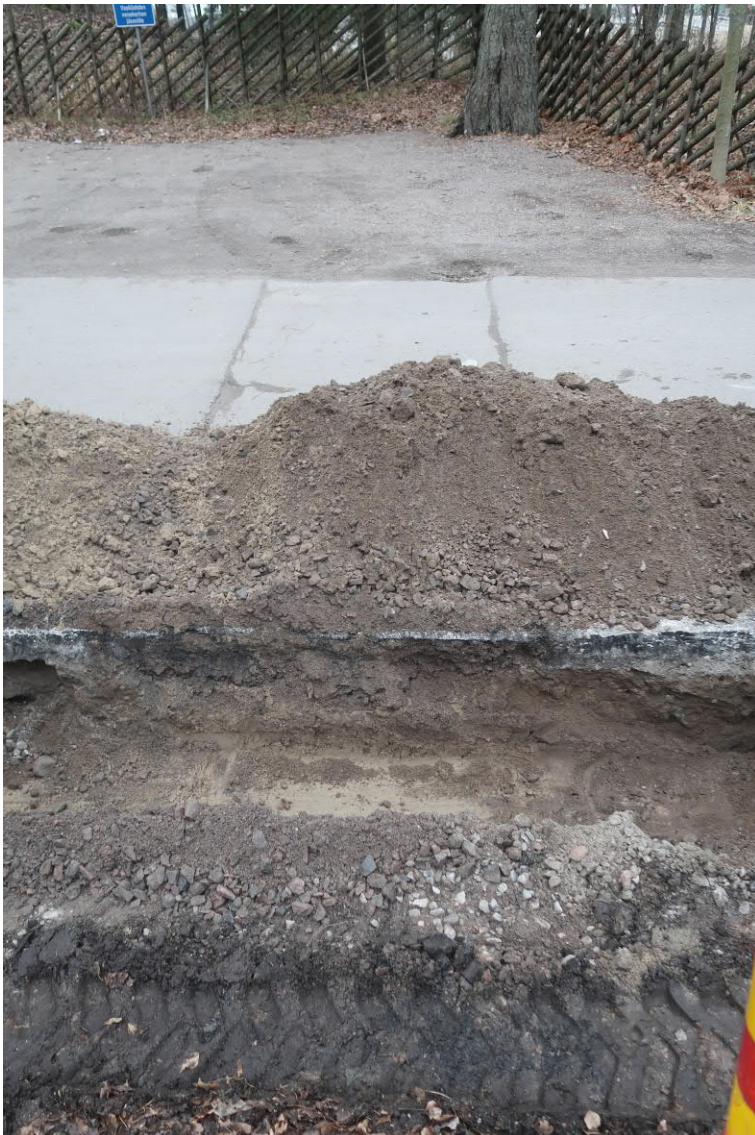
Kuva 28. Asfaltissa näkyy paikkausjälki, missä kaukolämpöputki tekee mutkan tien etelälaitaan. Kohta näkyy jo edellisen kuvan alalaidassa. Kaivannon täyttömaa on tässä vaaleaa hienoa hiekkaa. Kuvaussuunta N. Kuva Heini Hämäläinen/HKM 21.11.2019.
