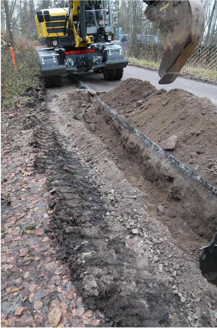
Kuva 4. Kaivuu etenee niemessä itäpästä alkaen. Kaivanto on noin 50 cm leveä, 50 cm syvä ja kaivannossa on vain hiekkaa ja soraa täytönä. Kuvaussuunta W. Kuva Heini Hämäläinen/HKM 20.11.2019.
