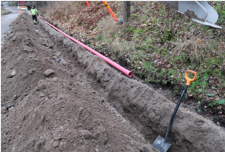
Kuva 21. Kaivuu on edennyt pitkälle länttä kohti suojahuoneen kummun kohdalla. Eteläprofiilissa samalla hiekaista, kivistä täyttöä. Kuvaussuunta E. Kuva Heini Hämäläinen/HKM 20.11.2019.
