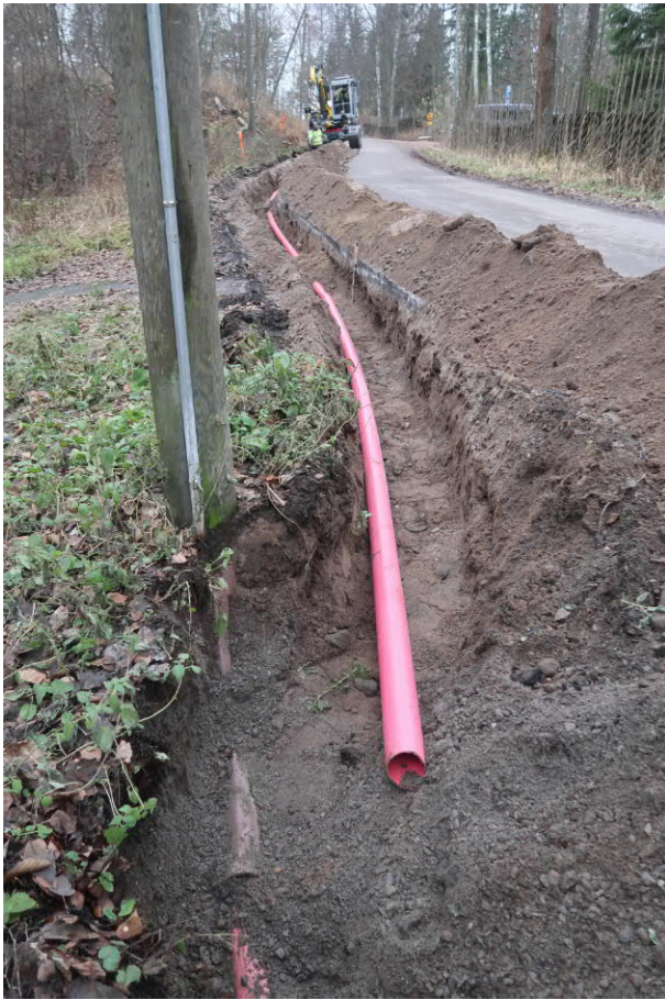
Kuva 8. Kaivuu lähti liikkeelle Vaskiniemen 'tyvessä' sijaitsevan sähköpylvään juurelta, ks. valvontakartta. Kuvaussuunta W. Kuva Heini Hämäläinen/HKM 20.11.2019.
