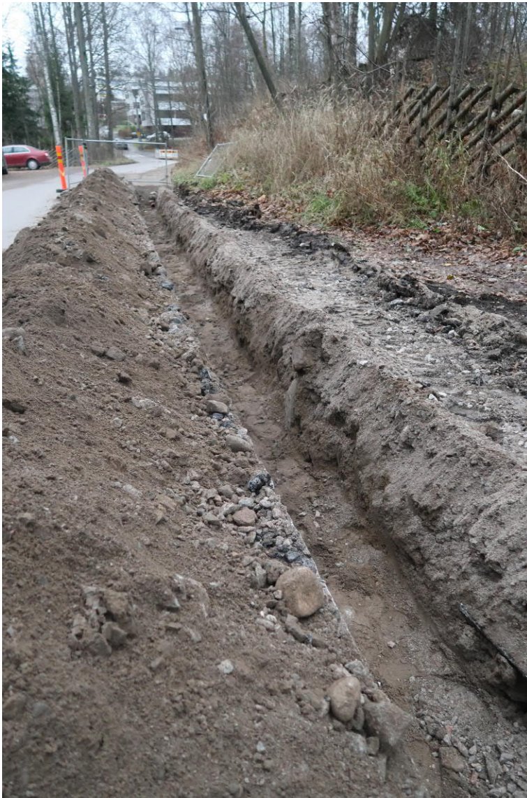
Kuva 23. Suojahuoneen kummun länsipuolelta on jo kaivettu maanokset. Kuvaussuunta E. Kuva Heini Hämäläinen/HKM 21.11.2019.
