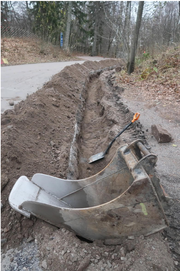
Kuva 36. Samaa kohtaa vastakkaisesta suunnasta. Tien molemmin puolin näkyy rintasuojan penkkaa. Kuvaussuunta E. Kuva Heini Hämäläinen/HKM 21.11.2019.
