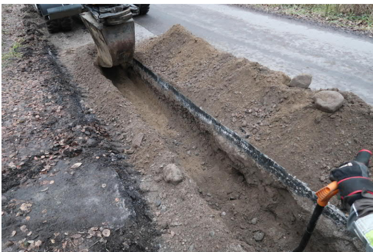
Kuva 5. Kuten edellä, kaivuu etenee kohti länttä. Asfaltin alla on noin 10 cm soraa ja sen alla keskikarkea ruskea, kivinen hiekka. Kuvaussuunta W. Kuva Heini Hämäläinen/HKM 20.11.2019.
