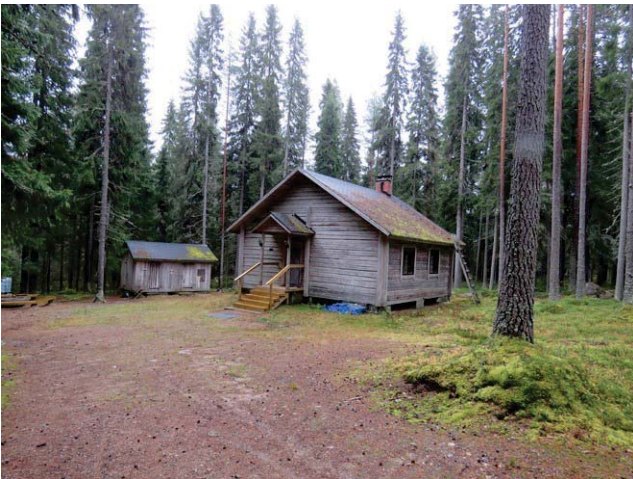
Nykyinen rakennus; tasanteella on perimätiedon mukaan sijainnut piilopirtti.
