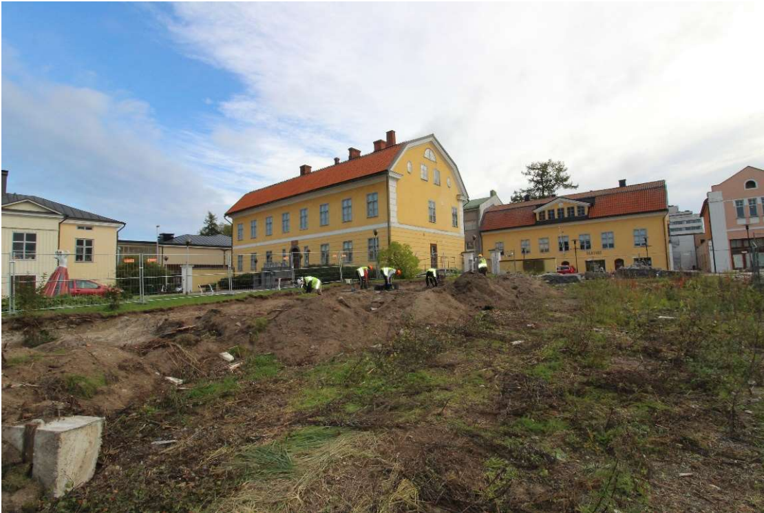
AKDG5598:235. Työkuva. Taustalla Roosin päärakennus. Kuvattu lounaasta. Kuvaaja Tuija Väisänen.
