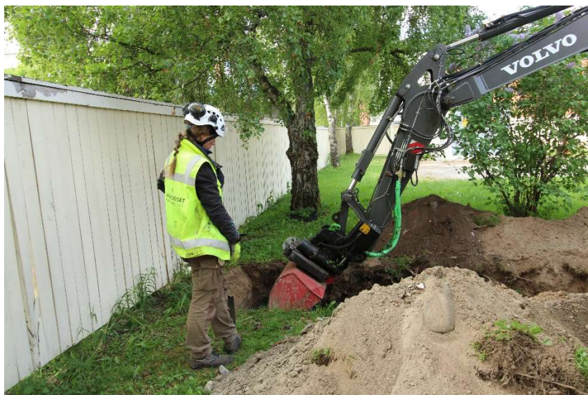
AKDG5598:125. Työkuva. Heli Lehto valvoo kaivinkonekaivua. Kuvaaja Tuija Väisänen.
