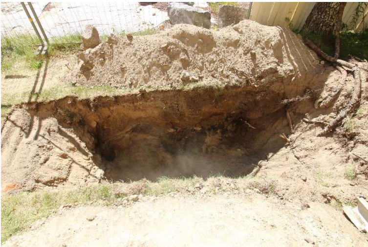
AKDG5598:101. Koeoja 1, eteläprofiili. Kuvattu pohjoisesta. Kuvaaja Tuija Väisänen.
