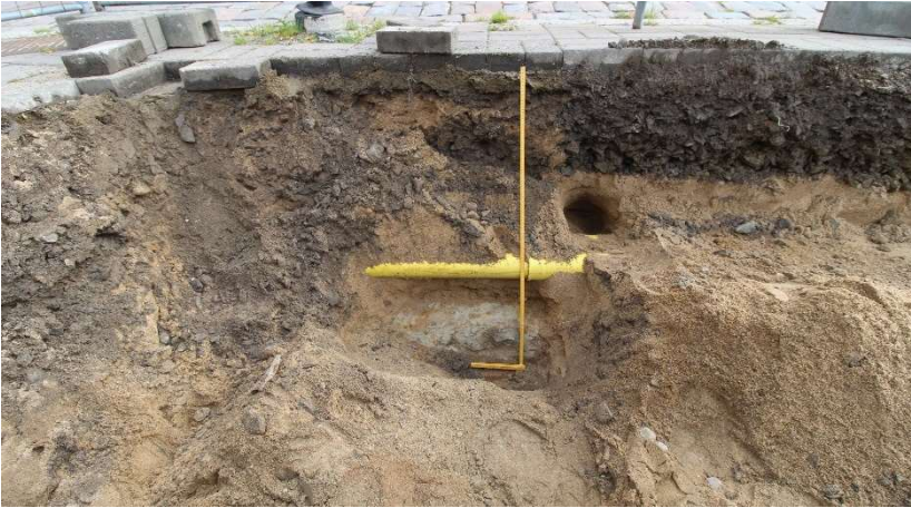
AKDG5598:3. Isokatu 7:n kaivausalueen pohjoispään laajennuksessa esiin tulleet putket sekä pohjamaa ja sen pystysuora kaivanto VL1. Lännestä. Kuvaaja Matleena Riutankoski.
