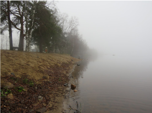
1. Pynttärinniemen itärannalla sijaitsevan uimarannan rantatörmää pohjoiseen.
