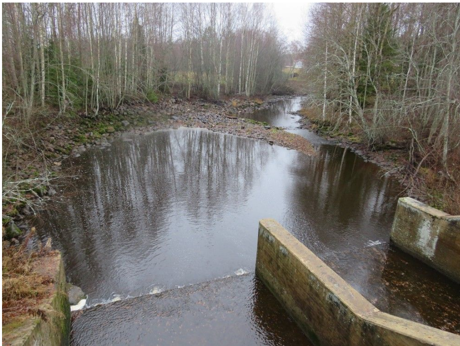
35. Koskenniskan nykyistä patoaluetta luoteeseen. Reipakan mylly sijaitti sen koillispuolella.
