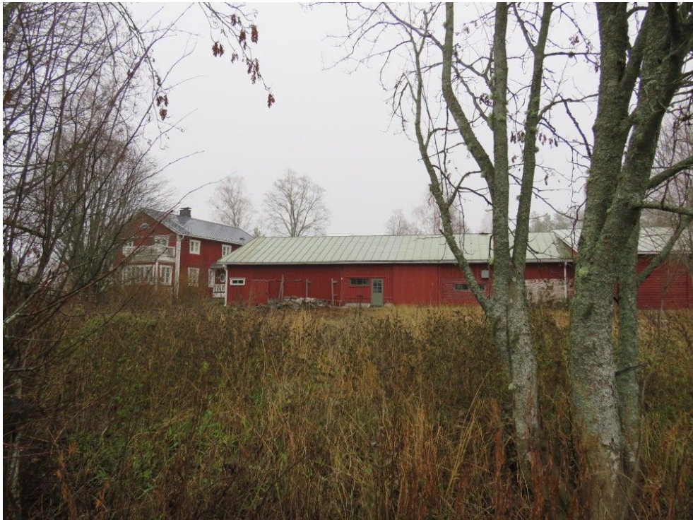
56. Pynttärin/Star-Pynttärin rakennuskantaa itään.
