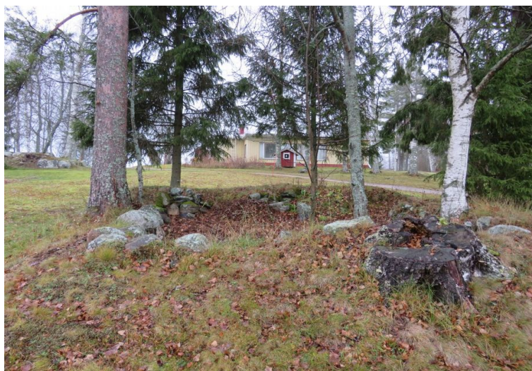
45. Kellarin perustus pohjoiseen.
