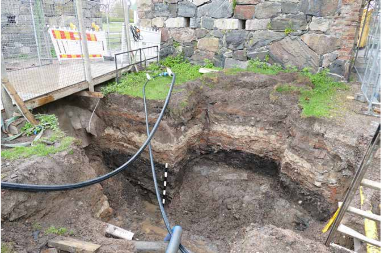
MuTu120015Dg_1. Yleiskuva kaivannon keskiosaan. Länsiprofiili, profiilit 1,2 ja 3 näkyvissä. Koillisesta, M. Helamaa, 11.5.2020.
