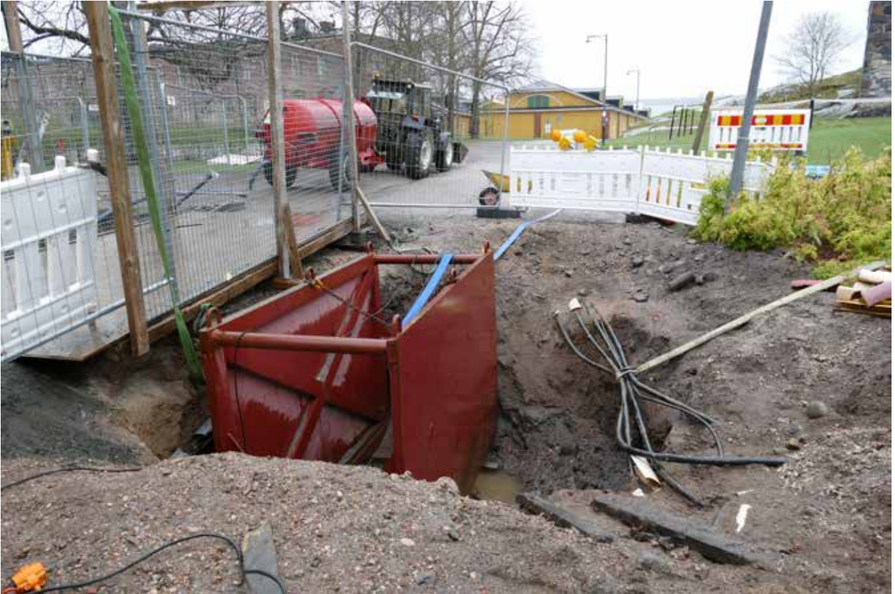
MuTu120015Dg_15. Yleiskuva kaivannon eteläpäädyssä. Lounaasta, M. Helamaa, 11.5.2020.
