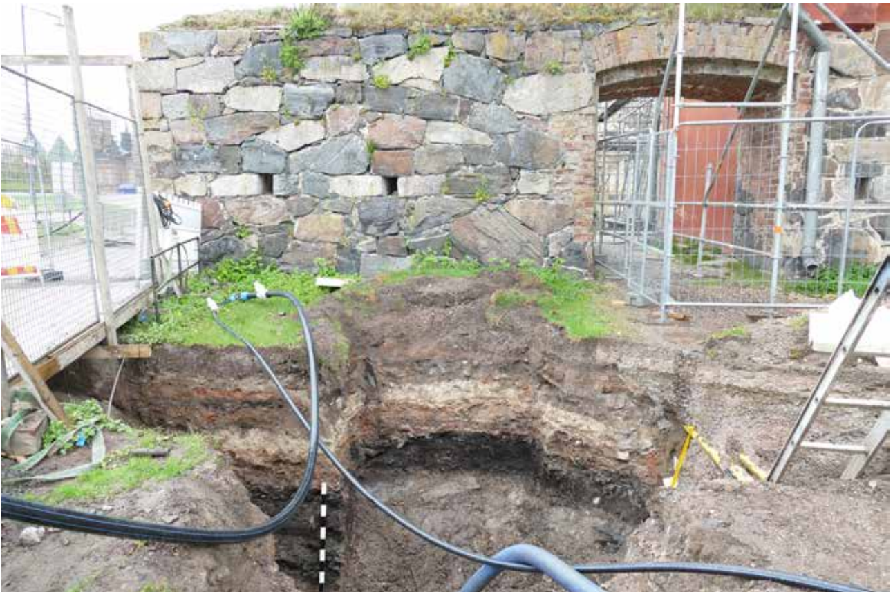
MuTu120015Dg_4. Yleiskuva länsiprofiiliin. Takana muuri rakennuksen C53 eteläpuolella. Idästä, M. Helamaa, 11.5.2020.
