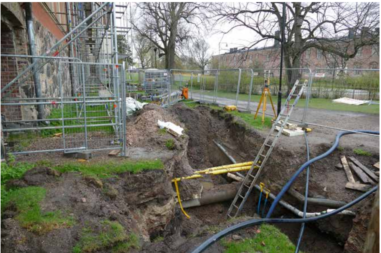
MuTu120015Dg_13. Yleiskuva kaivannon pohjoisosiin, putket kulkevat itäseinämällä. Lounaasta, M. Helamaa, 11.5.2020.
