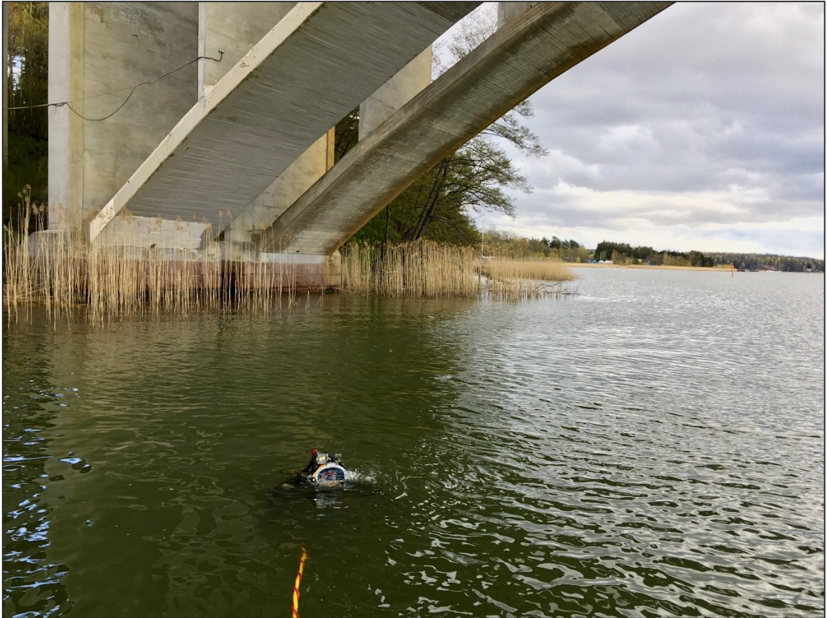
Kuva 11. Simo Nyrönen tarkastussukelluksella sillan pohjoispäädystä; kuvaussuunta itään. Kuvaaja: Inkeri Pekkanen.
